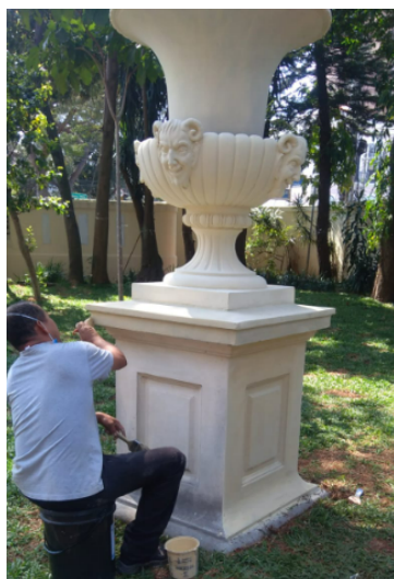
FOTO 53: Conservação vasos do jardim, processo de revisão do revestimento.
