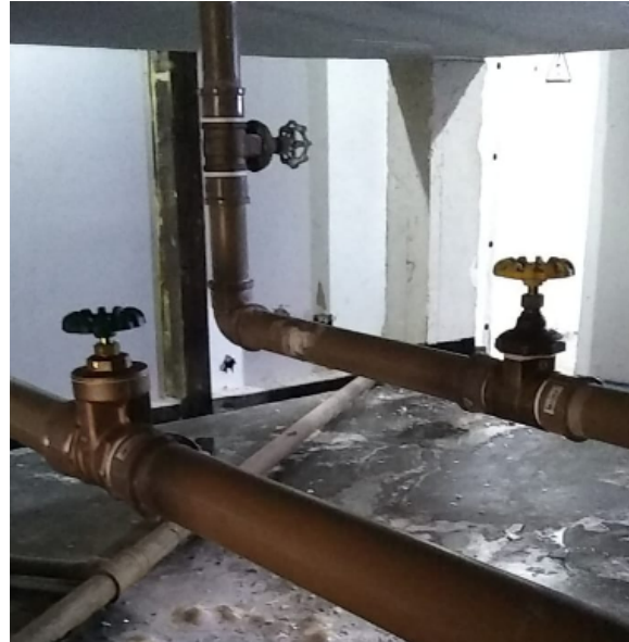
FOTO 12: Adequação do barrilhete hidráulico de água potável superior para abastecimento de água nos sanitários, instalação de válvulas de controle.
