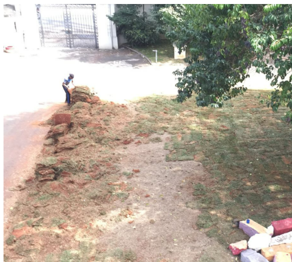
FOTO 37: Conservação área externa, preparação do solo para plantio de grama.
