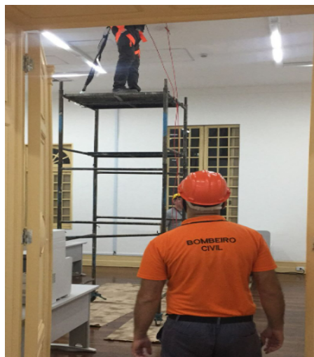
FOTO 81: Implantação de estrutura de rede Wireless no primeiro pavimento, salas de trabalho.
