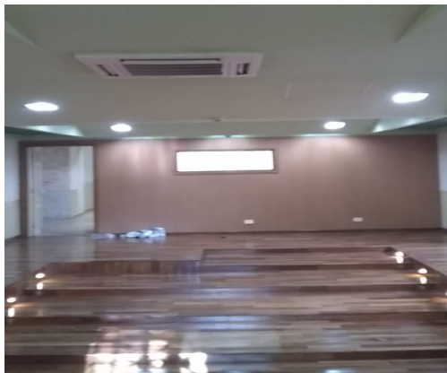
FOTO 35: Conservação iluminação dos interiores, auditório.
