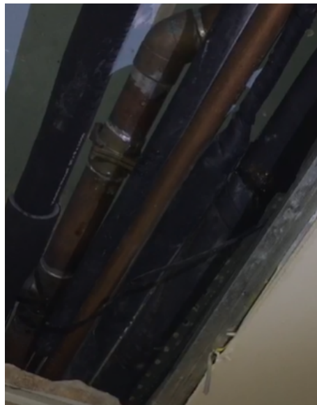
FOTO 72: Manutenção emergencial da tubulação de água dos hidrantes do térreo, sobre o forro do pavimento inferior.
