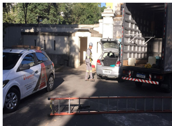
FOTO 8: Atividade de manutenção corretiva cabine primária pela equipe de conservação elétrica, mobilização da estrutura durante o tempo de atendimento da concessionária.
