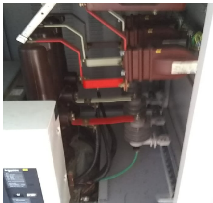
FOTO 3: Atividade de manutenção corretiva do ramal de entrada de média tensão, entrada dos condutores para TPS e TCS.
