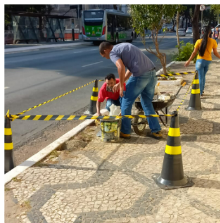
FOTO 22: Conservação revestimento da calçada frontal da Avenida Rio Branco, reposição do revestimento e obturação para assentamento.
