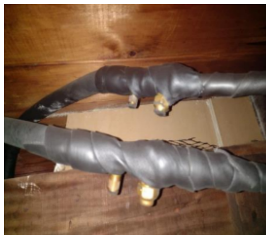
FOTO 30: Manutenção corretiva de vazamento de fluido do sistema de climatização, revisão das válvulas e do isolamento térmico.
