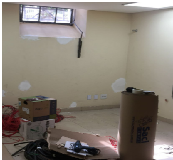
FOTO 85: Preparação da sala do futuro CPD, recuperação civil.
