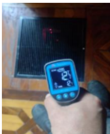
FOTO 33: Ativação do sistema de climatização, teste operacional dos equipamentos com insuflamento inferior.
