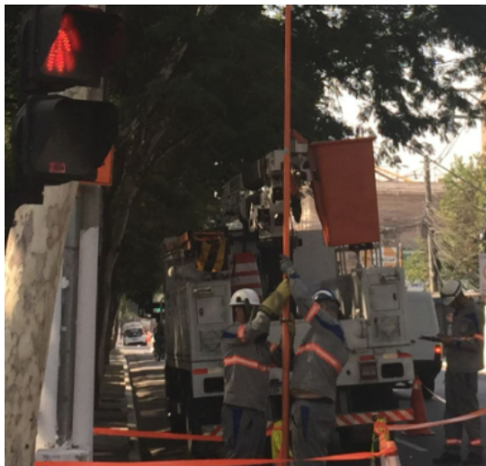
FOTO 5: Atividade de manutenção corretiva, atendimento Enel, para manutenção dos dispositivos de segurança do poste da rede aérea.
