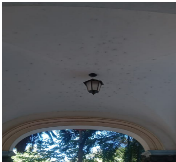
FOTO 79: Higienização do forro dos acessos do hall do térreo.
