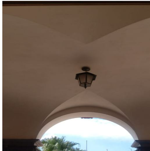
FOTO 80: Higienização do forro dos acessos do hall do térreo.
