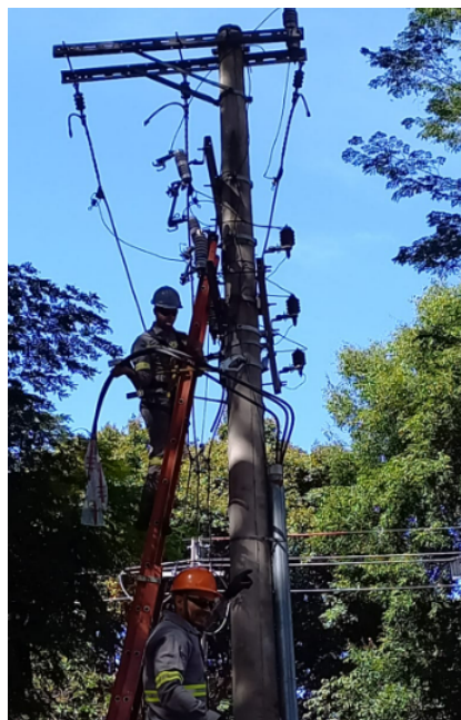
FOTO 9: Diagnóstico: Manutenção corretiva cabine primária, substituição do ramal de entrada.
