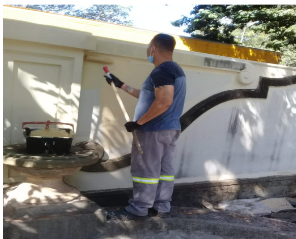
FOTO 57: Início da conservação muro do perímetro, pintura.
