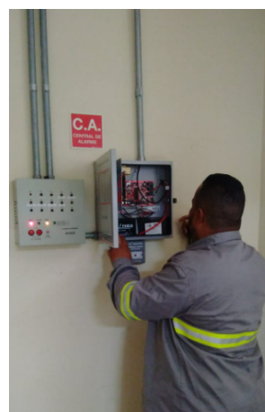
FOTO 74: Manutenção corretiva central de monitoramento dos detectores de fumaça.
