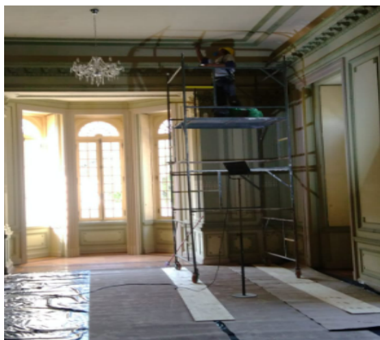
FOTO 65: Início da conservação do forro da sala de multiuso do térreo, sala, que abrigara mostra para abertura ao público.
