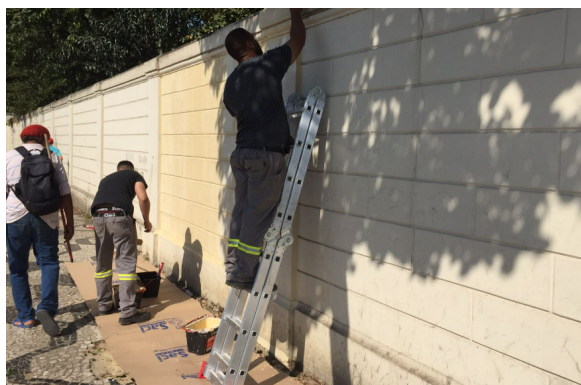
FOTO 61: Pintura do muro frontal da Avenida Rio Branco.
