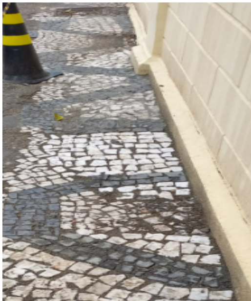
FOTO 19: Conservação revestimento da calçada frontal da Avenida Rio Branco.
