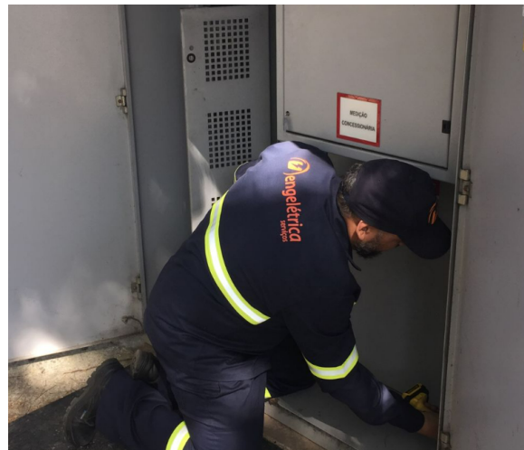
FOTO 6: Atividade de manutenção corretiva cabine primária pela equipe de conservação elétrica.
