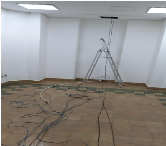
FOTO 83: Implantação de estrutura de rede, pavimento inferior.
