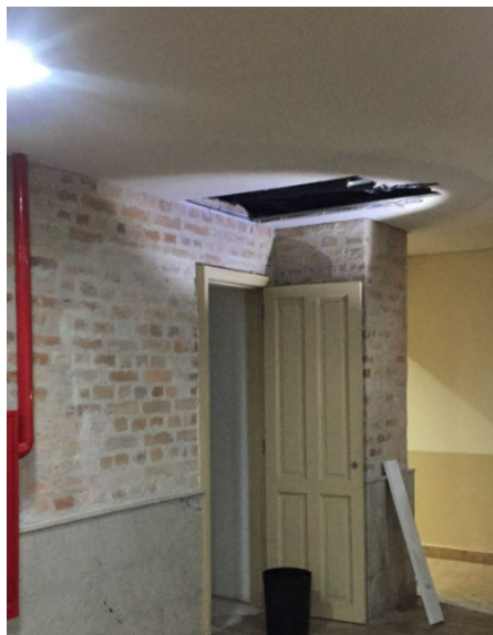
FOTO 71: Manutenção emergencial da tubulação de água dos hidrantes do térreo.
