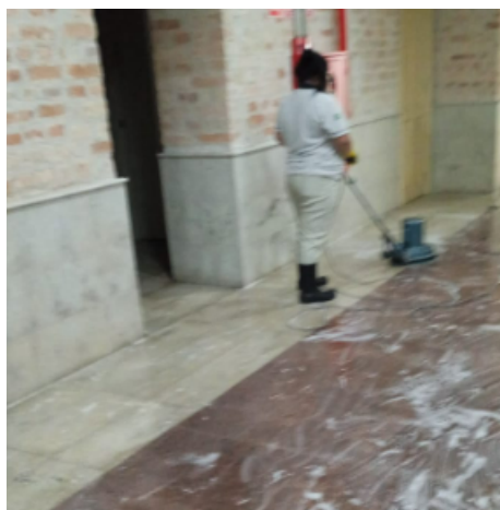
FOTO 93: Processo de teste e confecção de protocolos para higienização dos pisos, hall sanitários pavimento inferior.
