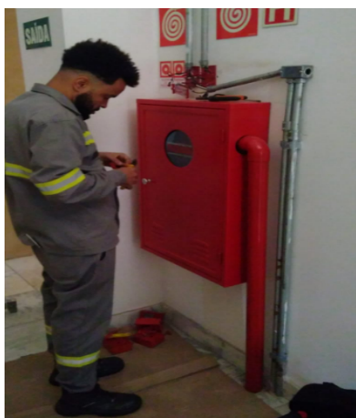
FOTO 73: Manutenção corretiva dos acionadores de incêndio.
