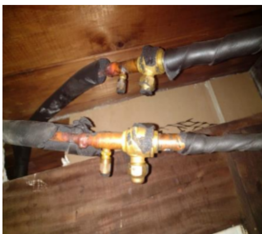
FOTO 29: Manutenção corretiva de vazamento de fluido do sistema de climatização.
