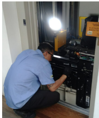
FOTO 18: Conservação e adequação dos elevadores de passageiros, instalação de dispositivos de segurança, kits das portas.
