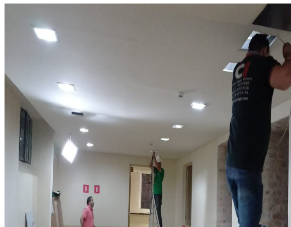
FOTO 68: Implantação de estrutura de cabeamento estruturado do pavimento inferior.
