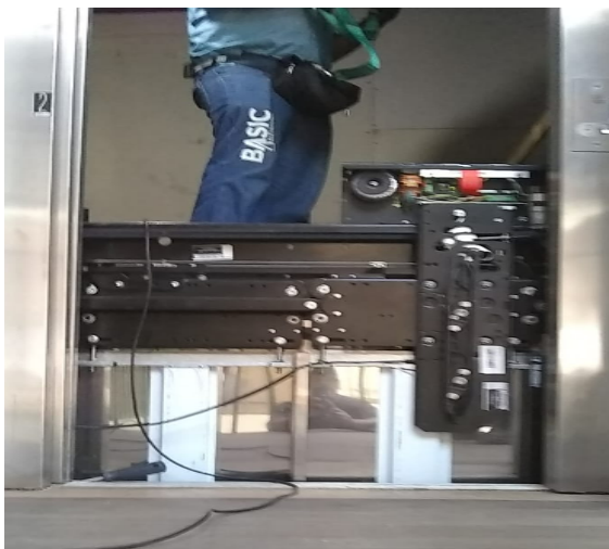
FOTO 17: Conservação e adequação dos elevadores de passageiros, instalação de dispositivos de segurança, kits das portas.
