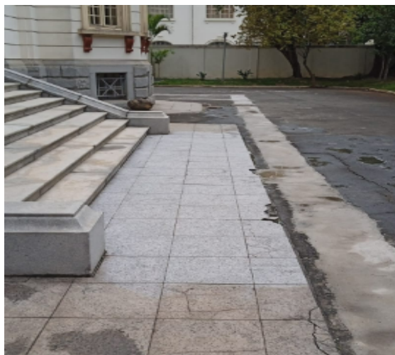
FOTO 89: Processo de teste e confecção de protocolos para higienização dos pisos, granito externo / escadaria.
