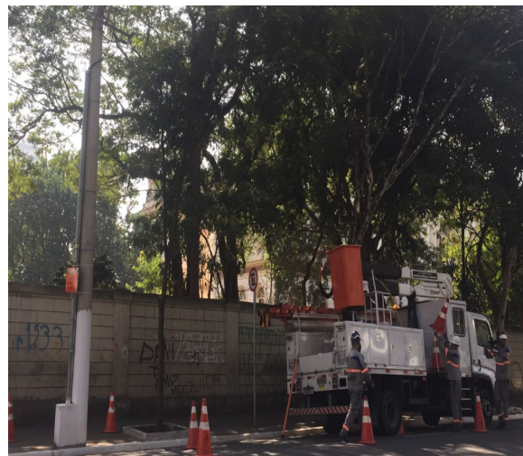
FOTO 2: Atividade de manutenção corretiva do ramal de entrada de média tensão, poste externo da concessionária, atendimento da Enel.
