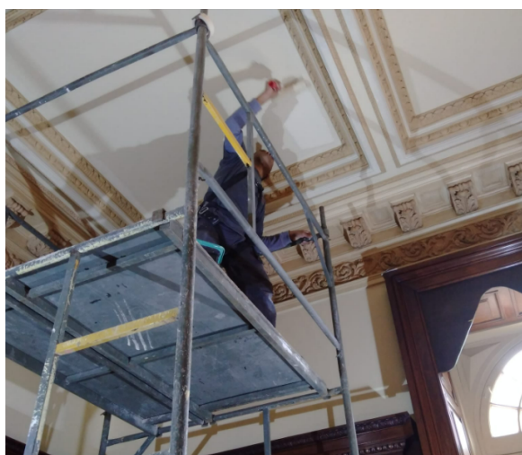
FOTO 49: Atividade de conservação do forro das salas de múltiplo uso.
