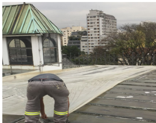
FOTO 78: Isolamento emergencial da cobertura, devido aos pontos de infiltração, localizado nas salas de máquina dos elevadores.
