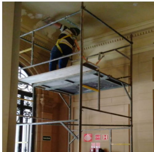
FOTO 56: Início da atividade de conservação do forro do hall principal, fechamento das aberturas.
