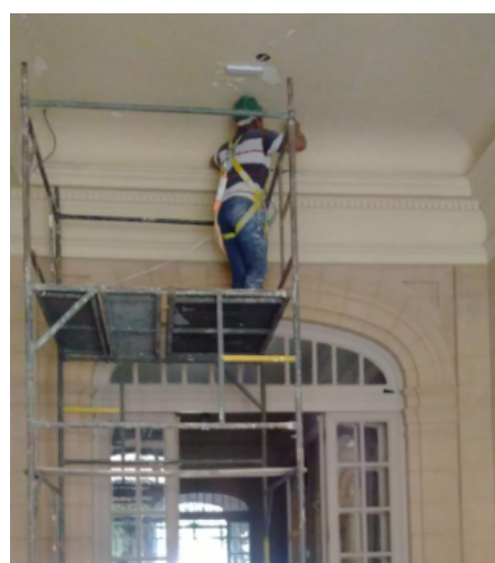
FOTO 50: Atividade de conservação do forro do corredor do térreo.
