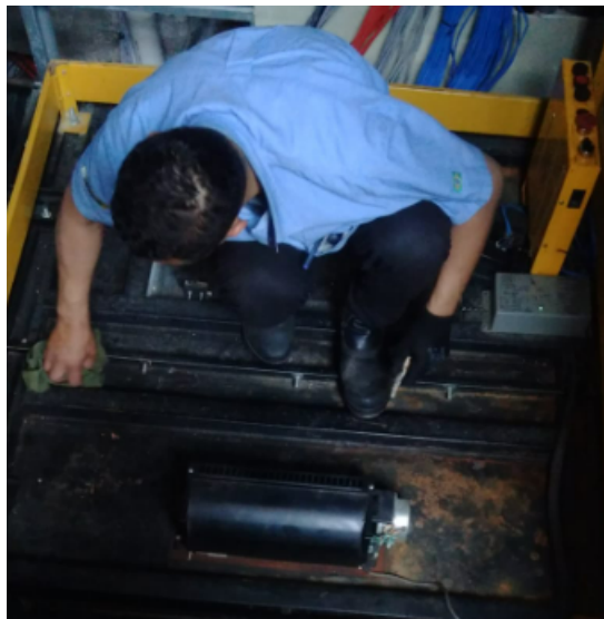
FOTO 15: Conservação e adequação dos elevadores de passageiros, instalação de dispositivos de segurança.
