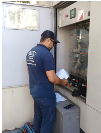
FOTO 24: Manutenção corretiva do Grupo Moto Gerador de Emergência, recuperação da capacidade de operação do sistema mecânico, teste com carga aplicada.
