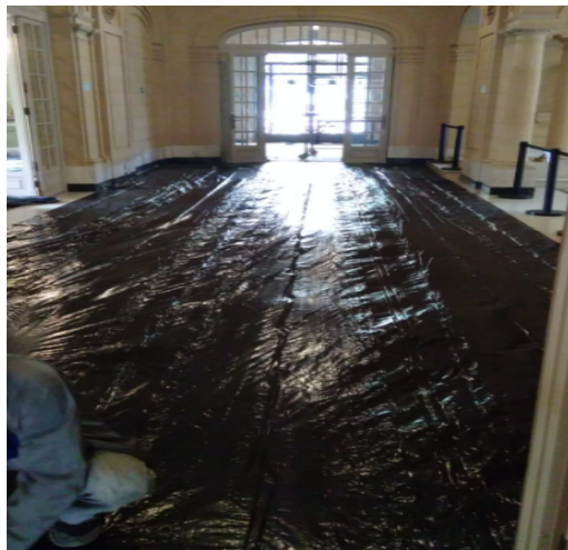
FOTO 55: Início da atividade de conservação do forro do hall principal.
