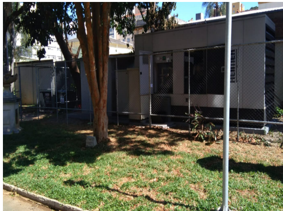
FOTO 23: Manutenção corretiva do Grupo Moto Gerador de Emergência, recuperação da capacidade de operação do sistema mecânico.
