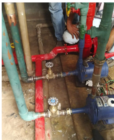
FOTO 14: Adequação do barrilhete hidráulico de água potável e reserva para incêndio, instalação de válvulas de controle.
