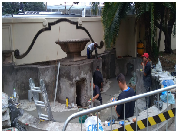
FOTO 47: Início da recuperação da capacidade funcional do chafariz, adequação civil e manutenção dos alimentadores de água.
