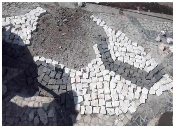
FOTO 21: Conservação revestimento da calçada frontal da Avenida Rio Branco, reposição do revestimento e obturação para assentamento.
