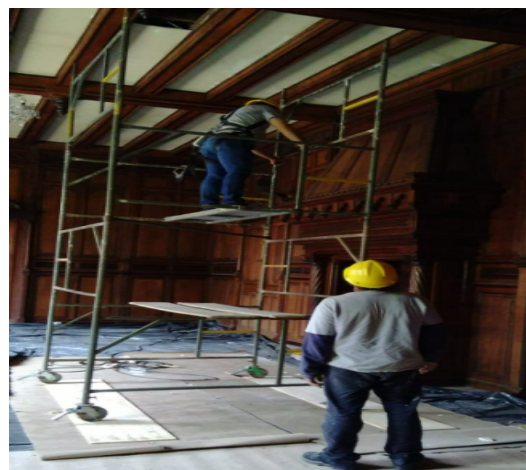
FOTO 46: Atividade de conservação, forro e acabamento térreo, sala da futura loja.
