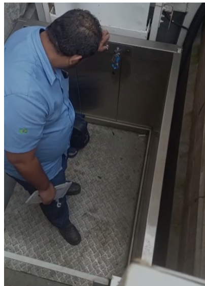
FOTO 16: Manutenção plataforma de acessibilidade, teste de operação mecânica.
