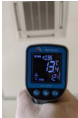
FOTO 32: Ativação do sistema de climatização, balanceamento da rede.
