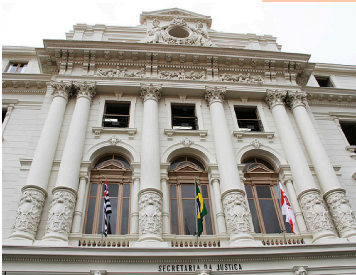
Fig. 06: Detalhe da arquitetura do novo prédio do Museu das Favelas, localizado no Pátio do Colégio. 8
