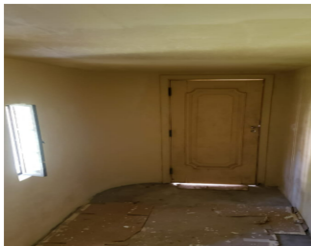
FOTO 81: Atividade de conservação de guaritas de vigilância.
