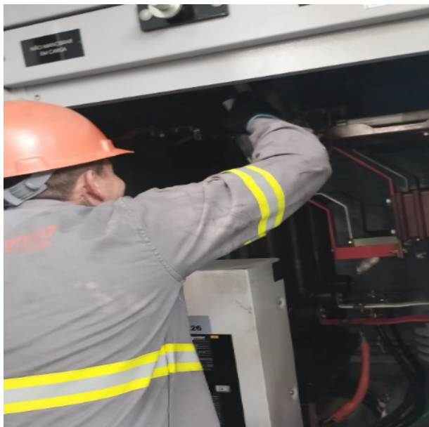
FOTO 74: Manutenção anual da cabine primária. Disjuntor de média.
