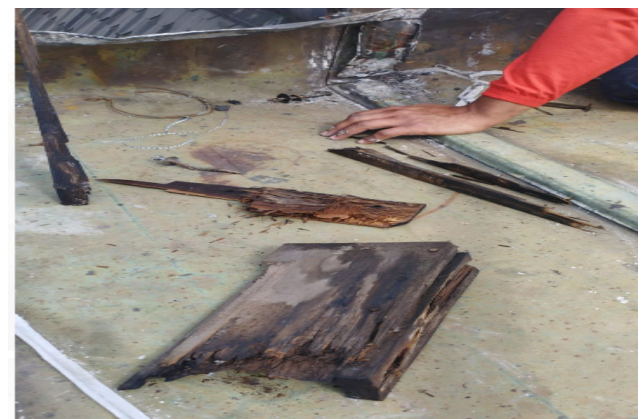
FOTO 8: Atividade de conservação da cobertura:
