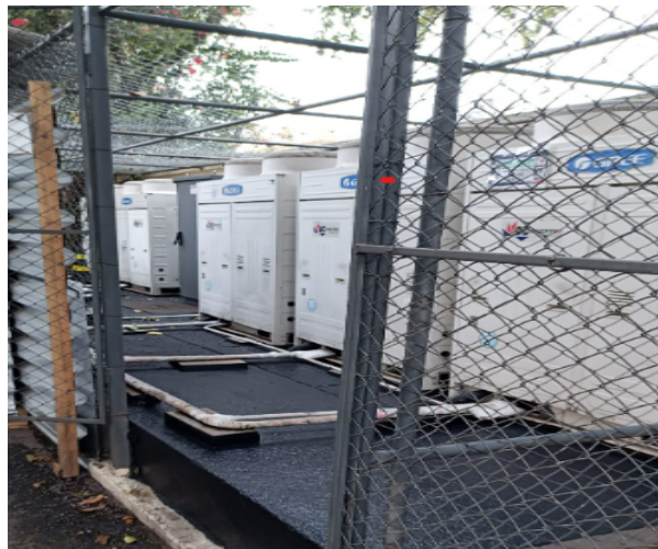
FOTO 91: Conservação de salas técnicas, pintura e demarcação do piso.
