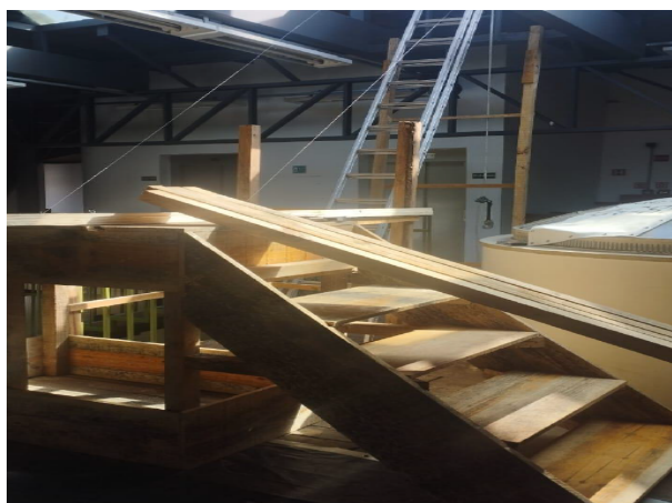
FOTO 5: Atividade de conservação da cobertura: Instalação de escada para acesso.
