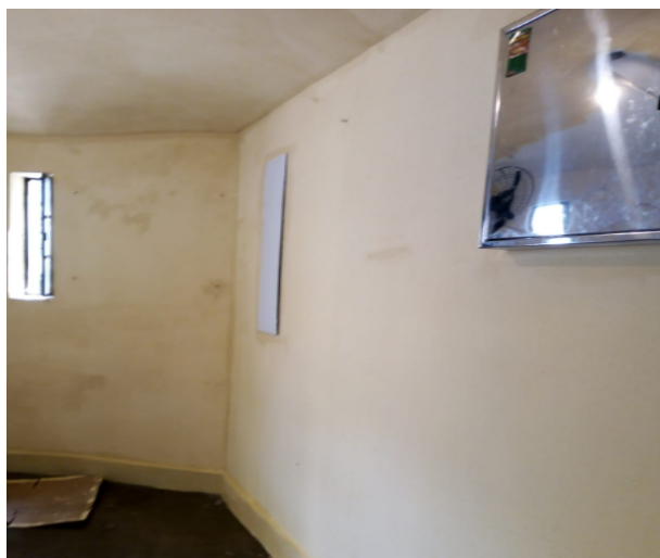
FOTO 84: Atividade de conservação de guaritas de vigilância.
