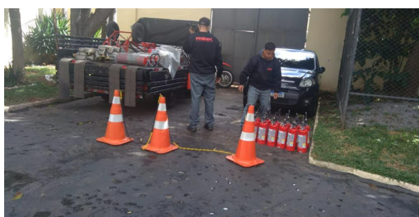
FOTO 35: Manutenção anual, recarga de extintores.
