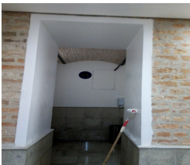
FOTO 62: Conservação dos banheiros no pavimento inferior.
