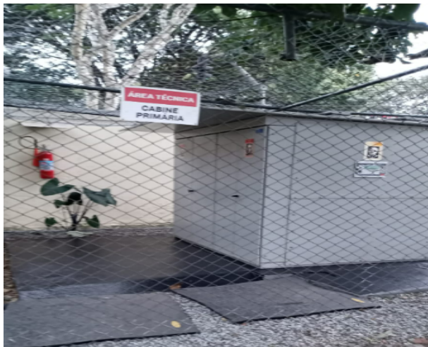
FOTO 90: Conservação de salas técnicas, pintura e demarcação do piso.
