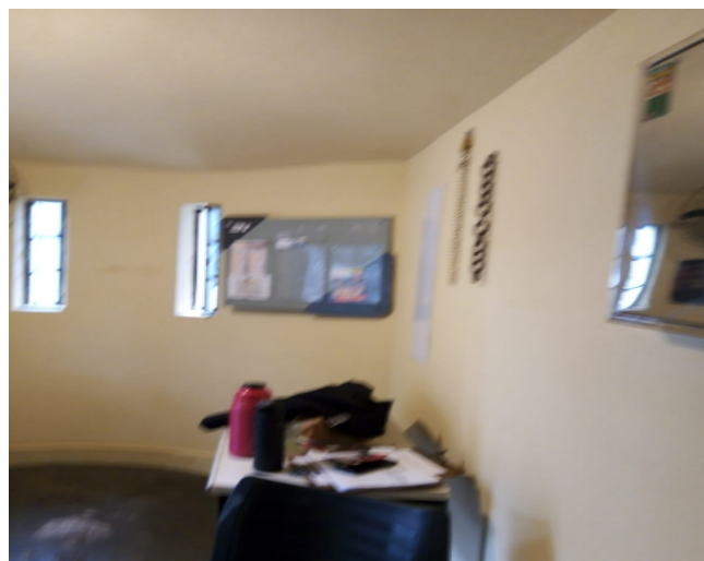
FOTO 85: Atividade de conservação de guaritas de vigilância.
