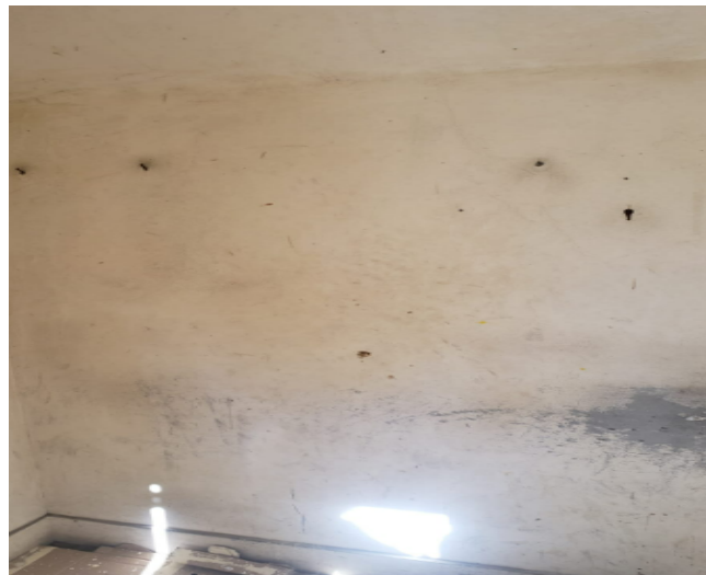
FOTO 83: Atividade de conservação de guaritas de vigilância.
