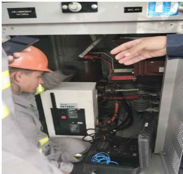
FOTO 75: Manutenção anual da cabine primária. Disjuntor de média.
