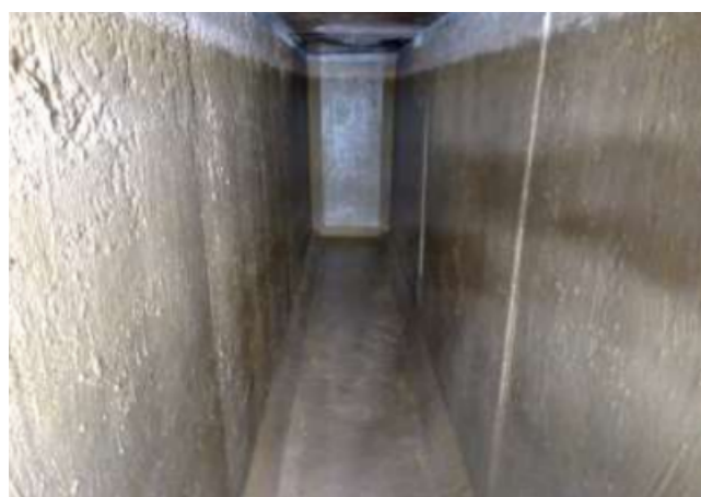
FOTO 32: Atividade de conservação, higienização de reservatórios de água.
