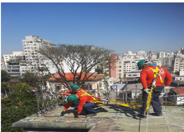
FOTO 17: Atividade de conservação da cobertura: Revisão gradil perimetral.
