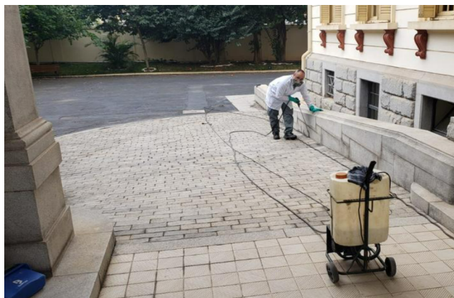
FOTO 77: Execução de barreira química anual preventiva para tratamento de cupins de solo.
