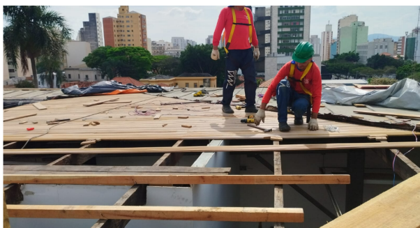
FOTO 15: Atividade de conservação da cobertura: Instalação de assoalho.
