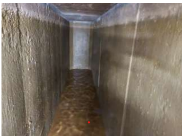
FOTO 31: Atividade de conservação, higienização de reservatórios de água.
