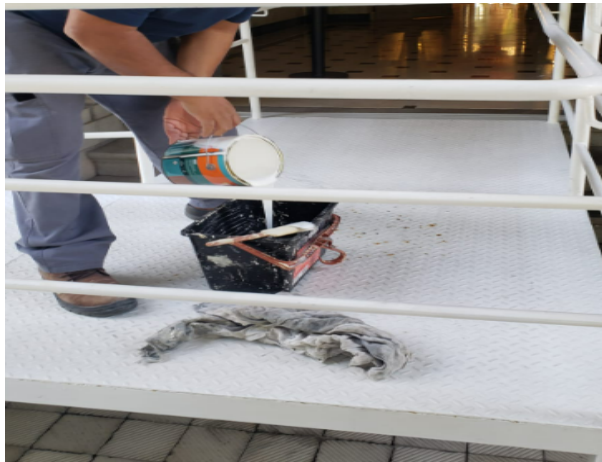
FOTO 64: Manutenção rampa de acessibilidade, pintura.
