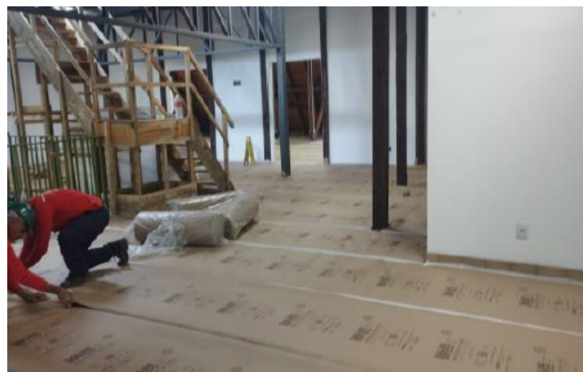
FOTO 4: Atividade de conservação da cobertura: Proteção do piso do pavimento Ático.
