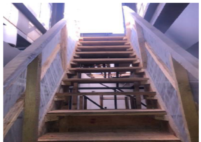
FOTO 6: Atividade de conservação da cobertura: Instalação de escada para acesso.
