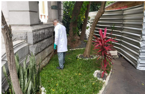
FOTO 78: Execução de barreira química anual preventiva para tratamento de cupins de solo.
