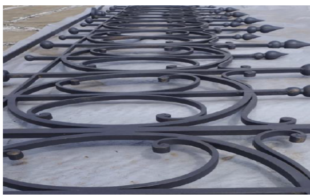
FOTO 20: Atividade de conservação da cobertura: Revisão e tratamento do gradil perimetral.
