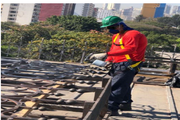
FOTO 19: Atividade de conservação da cobertura: Revisão e tratamento do gradil perimetral.
