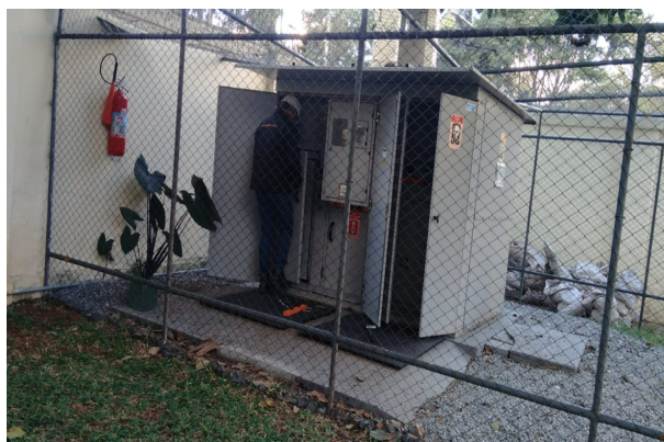
FOTO 70: Manutenção anual da cabine primária.
