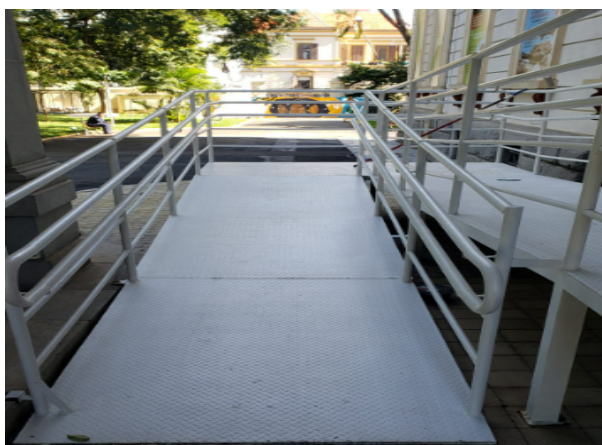
FOTO 66: Manutenção rampa de acessibilidade, pintura.
