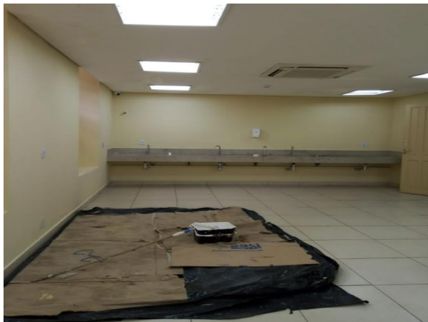
FOTO 60: Manutenção de salas técnicas, prestadores de serviço, pintura.
