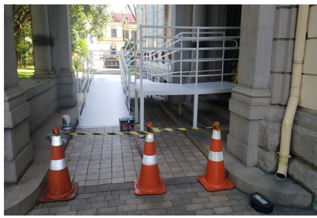
FOTO 67: Manutenção rampa de acessibilidade, pintura.
