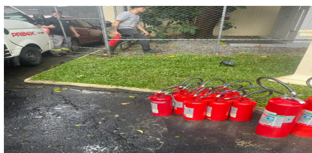
FOTO 36: Manutenção anual, recarga de extintores.
