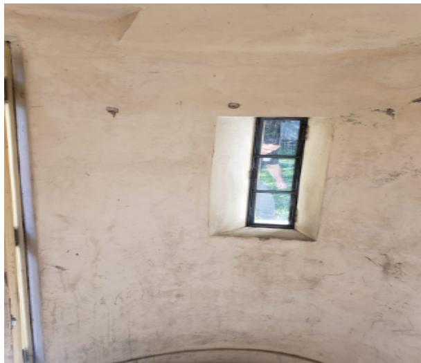
FOTO 82: Atividade de conservação de guaritas de vigilância.
