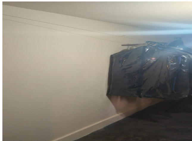
FOTO 87: Atividade de conservação de guaritas de vigilância.
