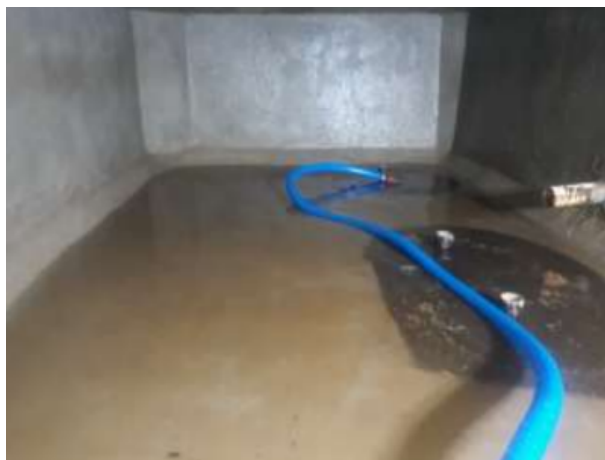
FOTO 33: Atividade de conservação, higienização de reservatórios de água.
