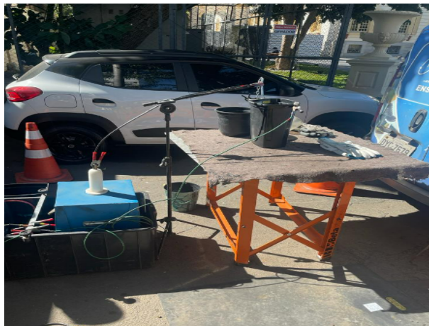
FOTO 68: Manutenção de equipamentos de proteção da cabine primária, testes.
