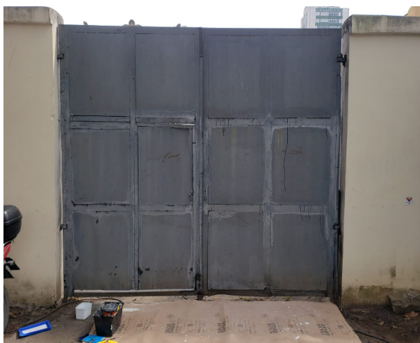
FOTO 88: Manutenção do portão de divisa do Museu das Favelas e 13º Batalhão de Policiamento Militar.
