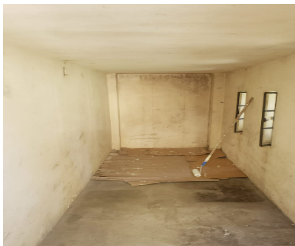
FOTO 80: Atividade de conservação de guaritas de vigilância.
