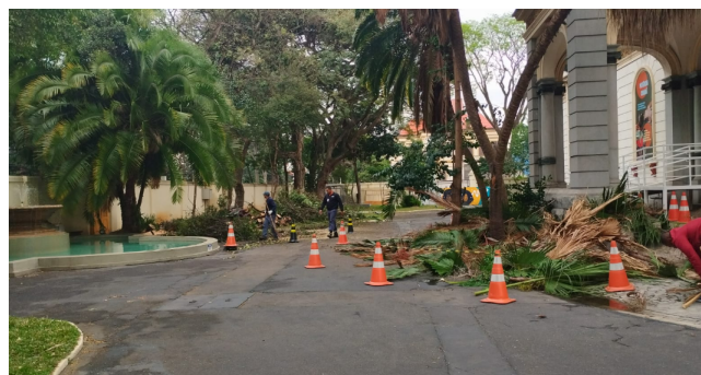
FOTO 24: Conservação do arboreto, poda e remoção.
