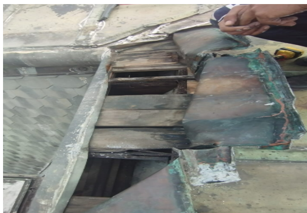
FOTO 7: Atividade de conservação da cobertura:
