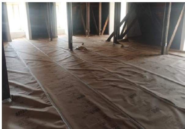
FOTO 3: Atividade de conservação da cobertura: Proteção do piso do pavimento Ático.
