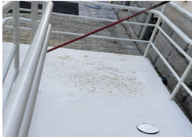
FOTO 65: Manutenção rampa de acessibilidade, pintura.
