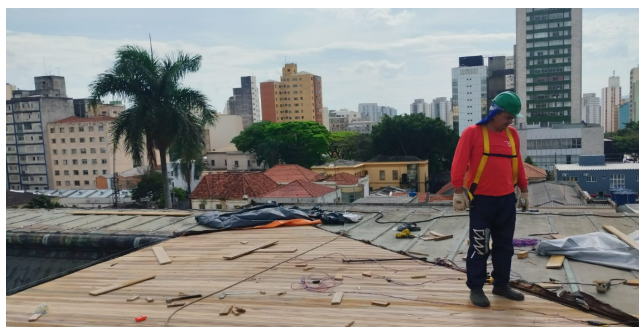
FOTO 16: Atividade de conservação da cobertura: Instalação de assoalho.
