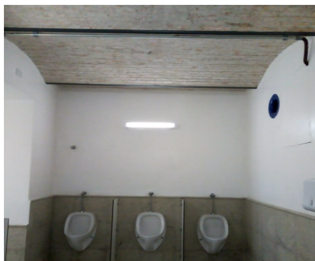
FOTO 63: Conservação dos banheiros no pavimento inferior.
