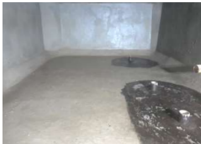
FOTO 34: Atividade de conservação, higienização de reservatórios de água.
