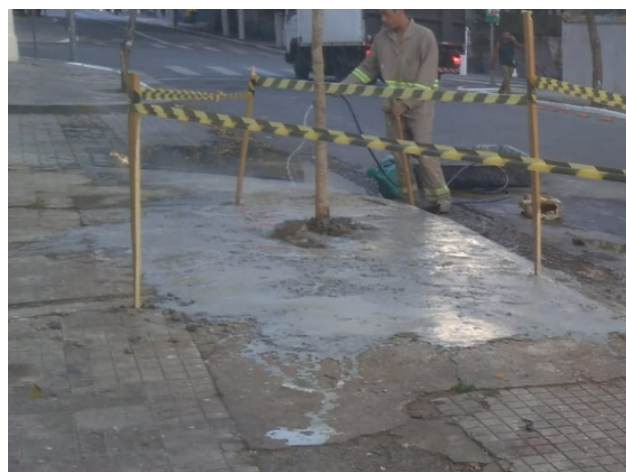
FOTO 93: Reparação de piso após atividade de remoção, e replantio de exemplar arbóreo, realizado pela Subprefeitura.
