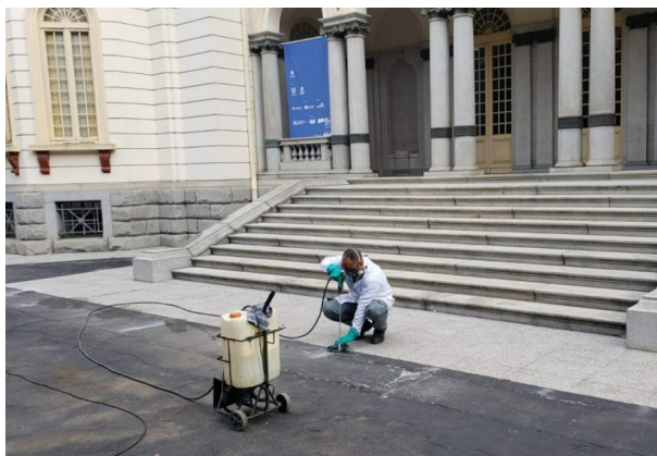
FOTO 76: Execução de barreira química anual preventiva para tratamento de cupins de solo.
