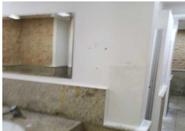
FOTO 61: Conservação dos banheiros no pavimento inferior.
