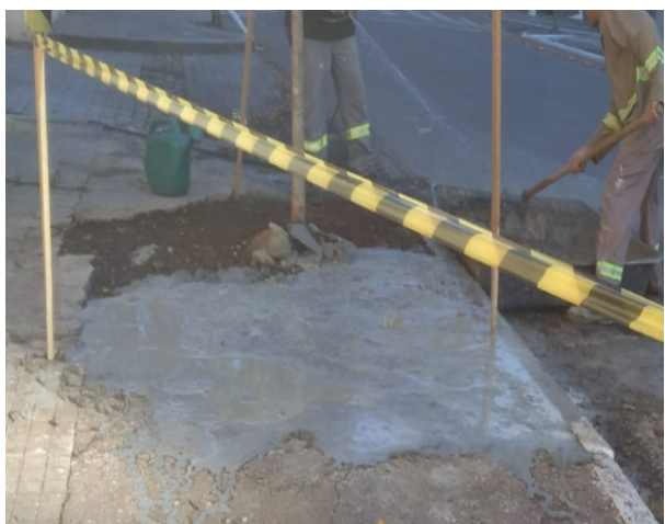
FOTO 92: Reparação de piso após atividade de remoção, e replantio de exemplar arbóreo, realizado pela Subprefeitura.
