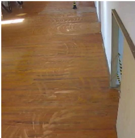
**FOTO 139:** Atividade de manutenção do piso do pavimento ático, calafetação dos pontos.
