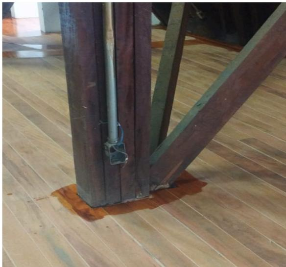
**FOTO 151:** Atividade de manutenção do piso do pavimento ático, acabamento e aplicação de verniz em toda extensão.
