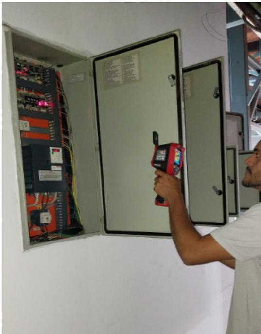
**FOTO 54:** Inspeção termográfica semestral dos quadros elétricos.
