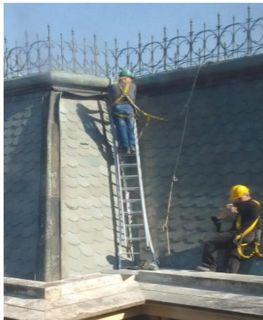
**FOTO 82:** Atividade de teste de estanqueidade da cobertura, revisão ardósia.
