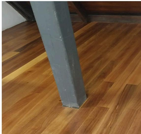
**FOTO 152:** Atividade de manutenção do piso do pavimento ático, acabamento e aplicação de verniz em toda extensão.
