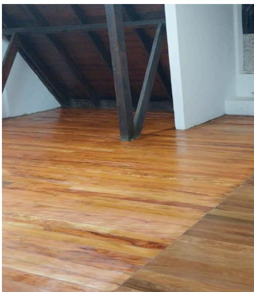
**FOTO 145:** Atividade de manutenção do piso do pavimento ático, acabamento e aplicação de verniz em toda extensão.
