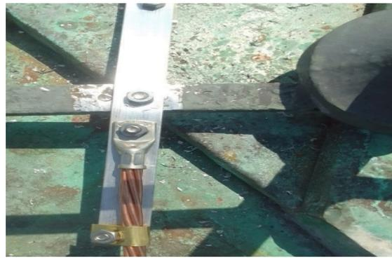
**FOTO 164:** Execução de serviço de adequação das instalações do SPDA (Sistema de Proteção contra Descargas Atmosféricas). Manutenção anual.
