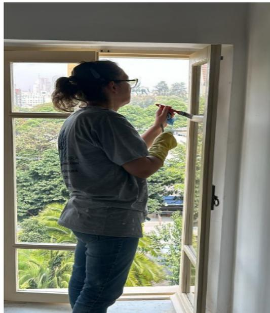
**FOTO 104:** Manutenção das janelas do pavimento ático.
