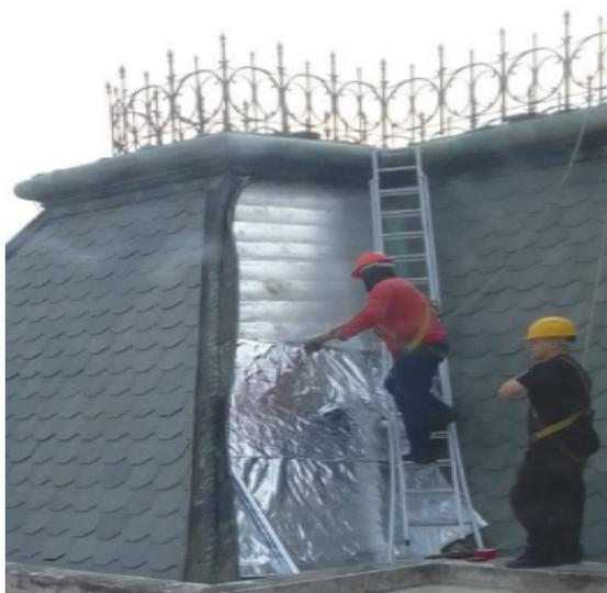
**FOTO 79:** Atividade de teste de estanqueidade da cobertura, revisão ardósia.
