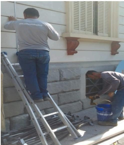
**FOTO 159:** Execução de serviço de adequação das instalações do SPDA (Sistema de Proteção contra Descargas Atmosféricas).
