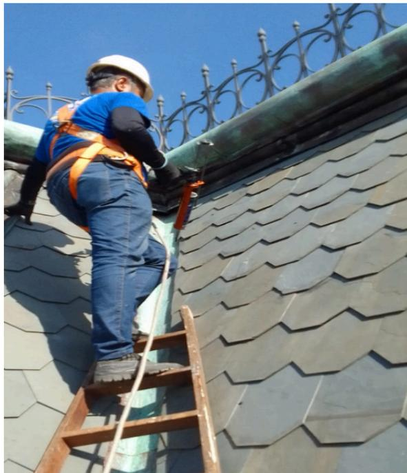
**FOTO 83:** Atividade de teste de estanqueidade da cobertura, revisão calhas e águas furtada.
