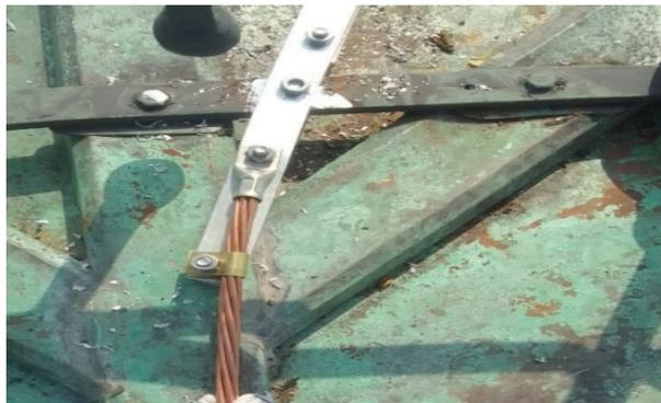
**FOTO 163:** Execução de serviço de adequação das instalações do SPDA (Sistema de Proteção contra Descargas Atmosféricas). Manutenção anual.
