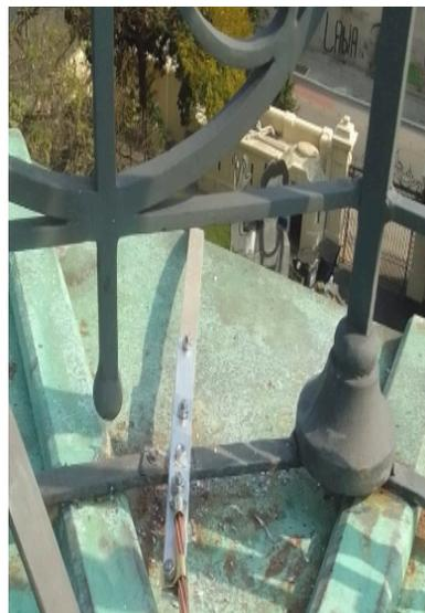
**FOTO 162:** Execução de serviço de adequação das instalações do SPDA (Sistema de Proteção contra Descargas Atmosféricas). Manutenção Anual.
