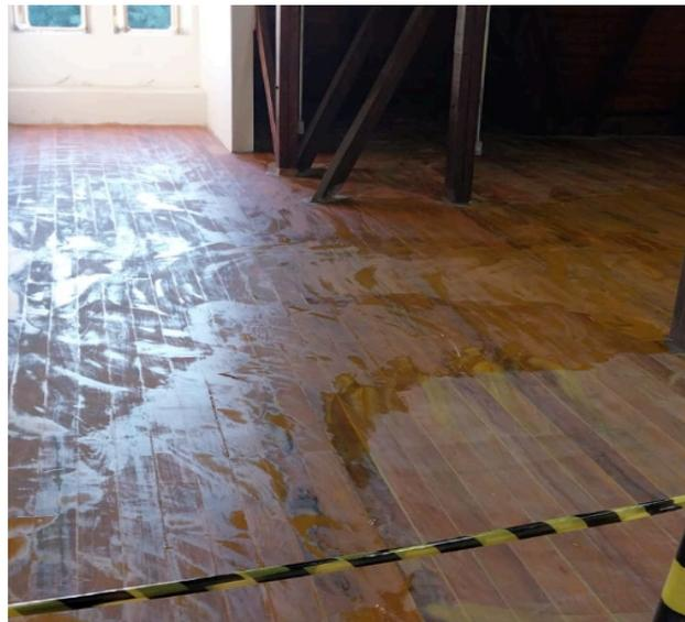
**FOTO 136:** Atividade de manutenção do piso do pavimento ático, calafetação dos pontos.
