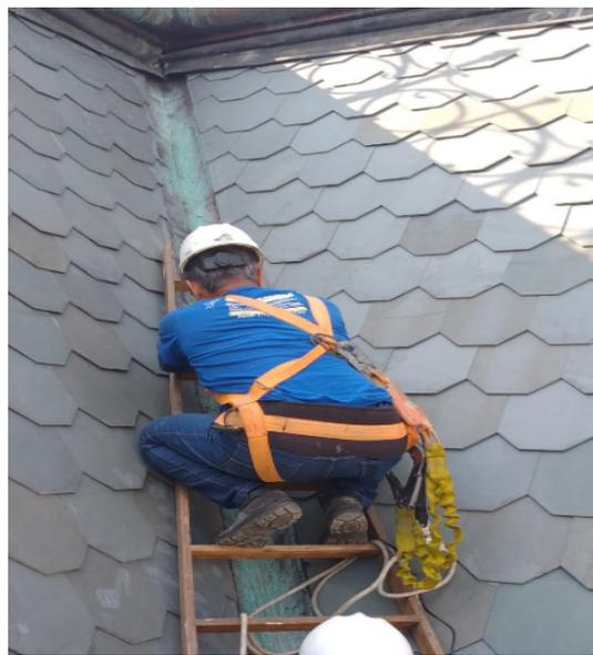
**FOTO 86:** Atividade de teste de estanqueidade da cobertura, revisão calhas e águas furtada.
