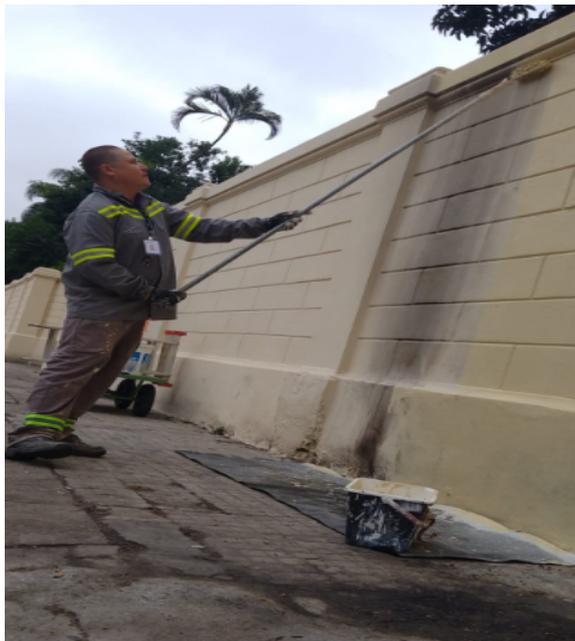
**FOTO 67:** Manutenção corretiva do revestimento da face externa dos muros perimetrais.
