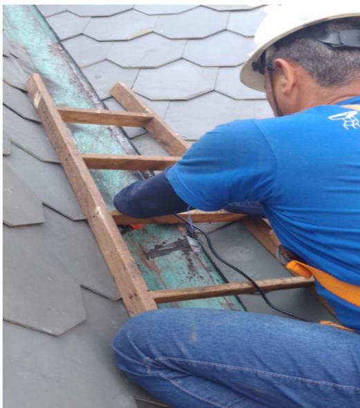
**FOTO 85:** Atividade de teste de estanqueidade da cobertura, revisão calhas e águas furtada.
