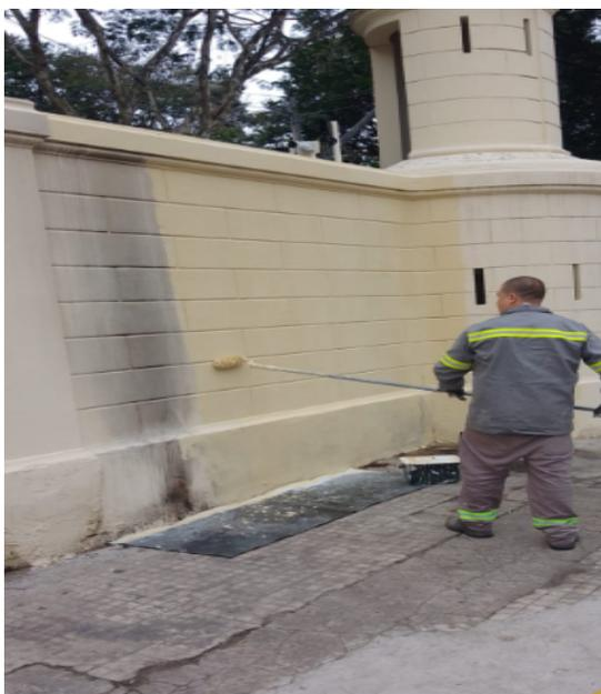
**FOTO 69:** Manutenção corretiva do revestimento da face externa dos muros perimetrais
