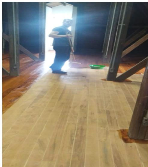
**FOTO 150:** Atividade de manutenção do piso do pavimento ático, acabamento e aplicação de verniz em toda extensão.
