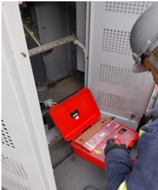
**FOTO 21:** Manutenção preventiva anual da cabine primária, testes de isolamento megagem dos condutores.
