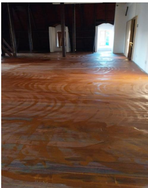
**FOTO 137:** Atividade de manutenção do piso do pavimento ático, calafetação dos pontos.
