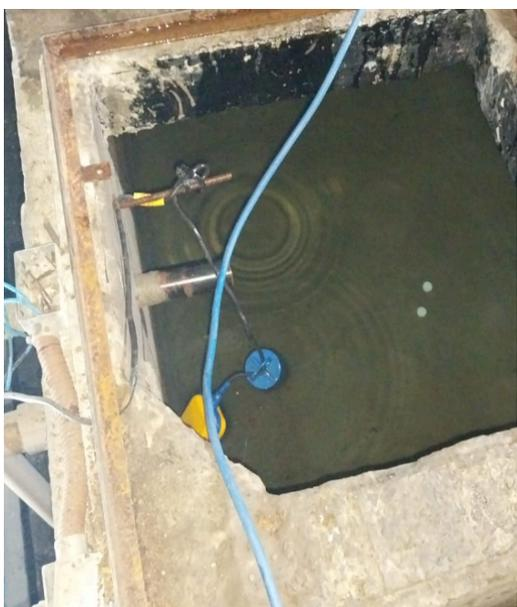
**FOTO 47:** Atividade de conservação para limpeza e desinfecção dos reservatórios de água potável, águas pluviais e esgoto.
