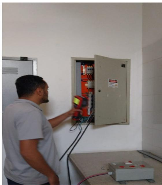
**FOTO 57:** Inspeção termográfica semestral dos quadros elétricos.
