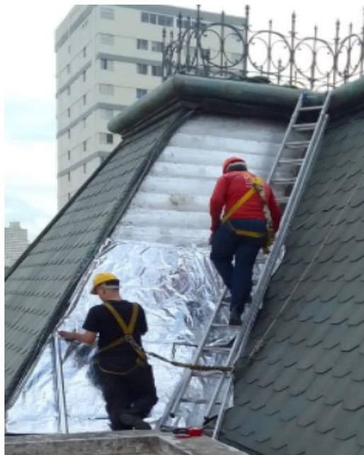
**FOTO 80:** Atividade de teste de estanqueidade da cobertura, revisão ardósia.
