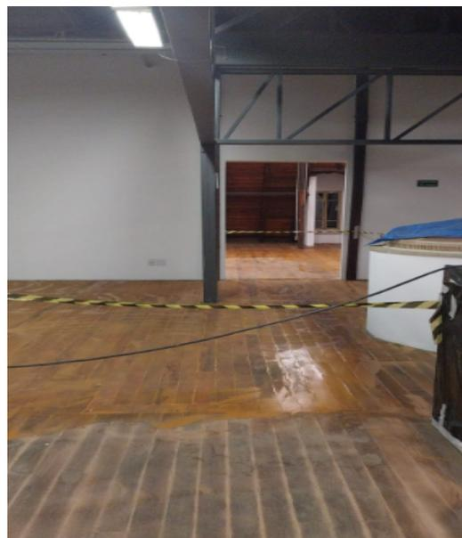
**FOTO 142:** Atividade de manutenção do piso do pavimento ático, calafetação dos pontos.
