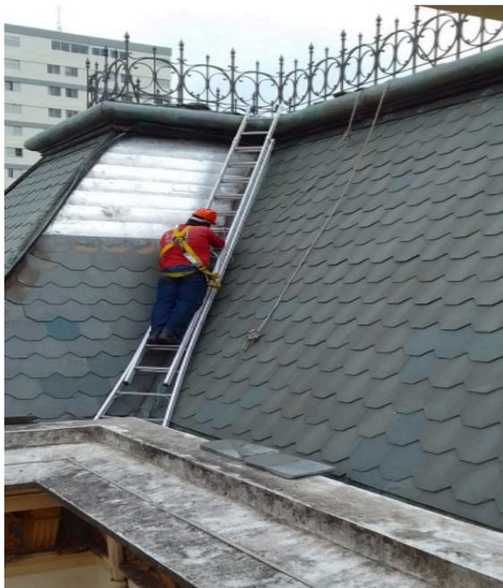
**FOTO 81:** Atividade de teste de estanqueidade da cobertura, revisão ardósia.
