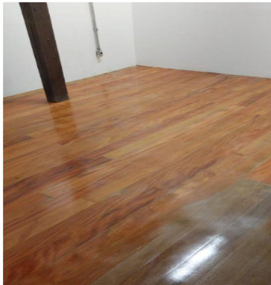
**FOTO 156:** Atividade de manutenção do piso do pavimento ático, acabamento e aplicação de verniz em toda extensão.
