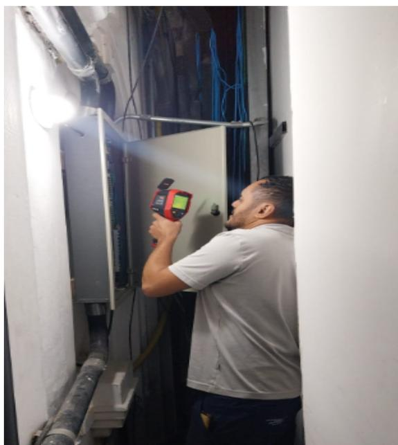
**FOTO 56:** Inspeção termográfica semestral dos quadros elétricos.
