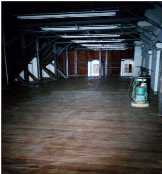
**FOTO 143:** Atividade de manutenção do piso do pavimento ático, calafetação dos pontos.
