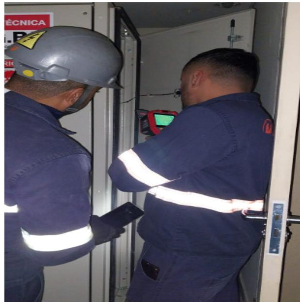
**FOTO 14:** Manutenção preventiva anual da cabine primária, inspeção quadro geral de baixa tensão.
