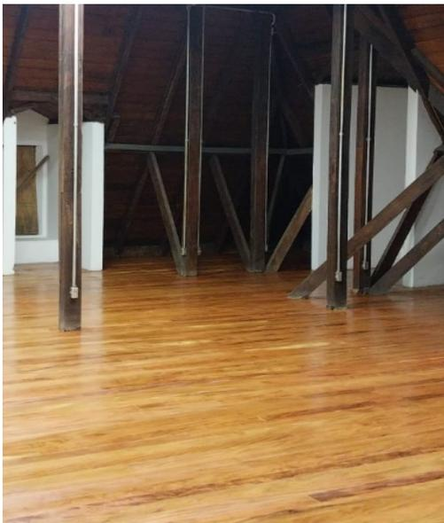
**FOTO 147:** Atividade de manutenção do piso do pavimento ático, acabamento e aplicação de verniz em toda extensão.
