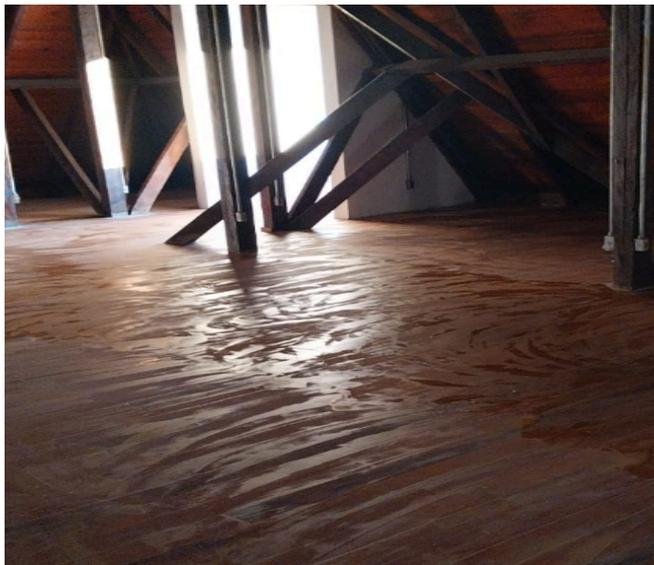
**FOTO 135:** Atividade de manutenção do piso do pavimento ático, calafetação dos pontos.
