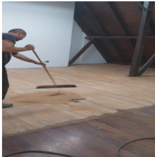
**FOTO 140:** Atividade de manutenção do piso do pavimento ático, calafetação dos pontos.
