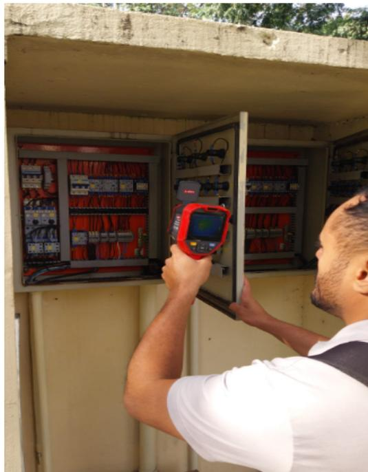
**FOTO 55:** Inspeção termográfica semestral dos quadros elétricos.
