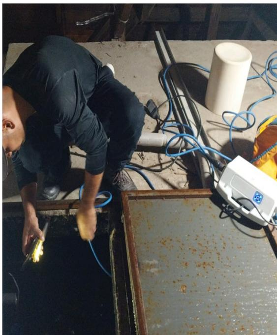
**FOTO 45:** Atividade de conservação para limpeza e desinfecção dos reservatórios de água potável, águas pluviais e esgoto.
