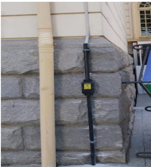
**FOTO 161:** Execução de serviço de adequação das instalações do SPDA (Sistema de Proteção contra Descargas Atmosféricas) Manutenção Anual.
