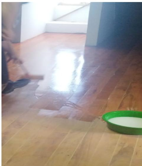
**FOTO 149:** Atividade de manutenção do piso do pavimento ático, acabamento e aplicação de verniz em toda extensão.
