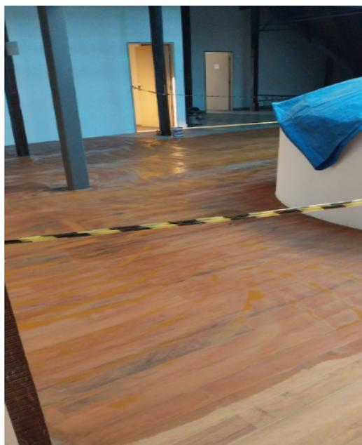
**FOTO 138:** Atividade de manutenção do piso do pavimento ático, calafetação dos pontos.
