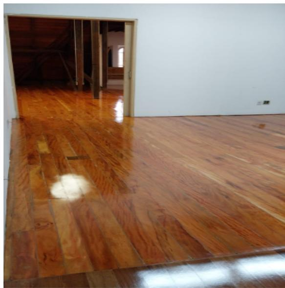
**FOTO 158:** Atividade de manutenção do piso do pavimento ático, acabamento e aplicação de verniz em toda extensão.
