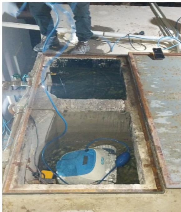
**FOTO 46:** Atividade de conservação para limpeza e desinfecção dos reservatórios de água potável, águas pluviais e esgoto.
