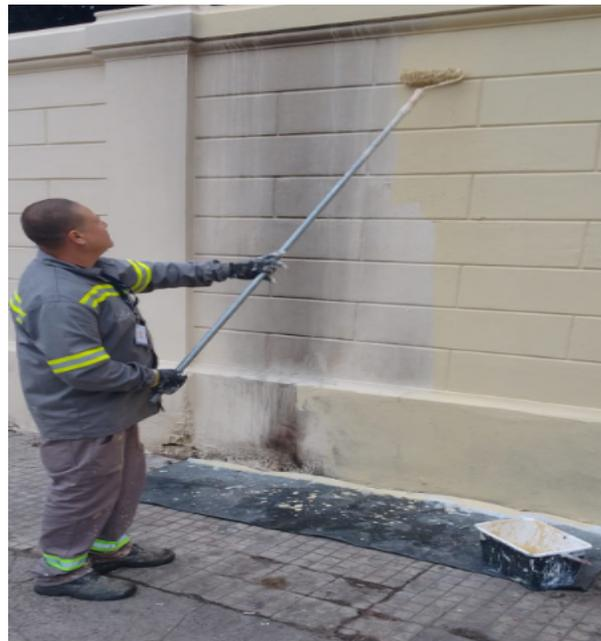
**FOTO 68:** Manutenção corretiva do revestimento da face externa dos muros perimetrais.
