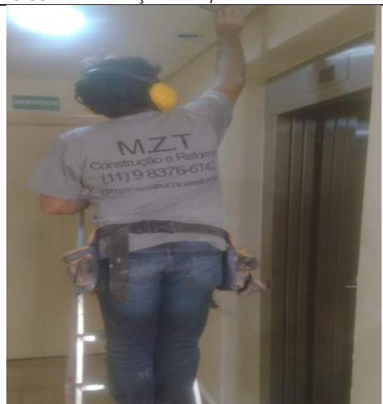
FOTO 55: Conservação civil pavimento inferior
