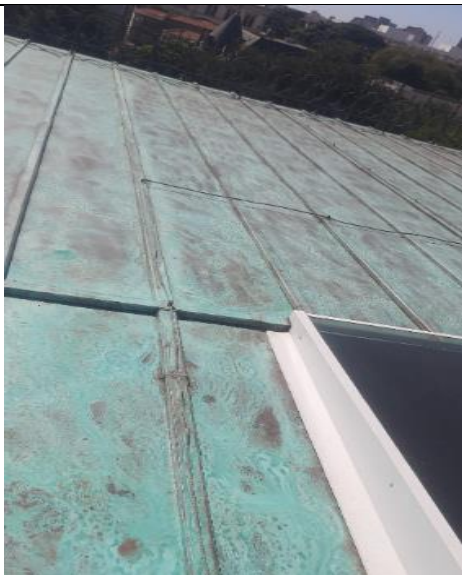
FOTO 145: Conservação cobertura, aplicação de acabamento de pátina artificial.
