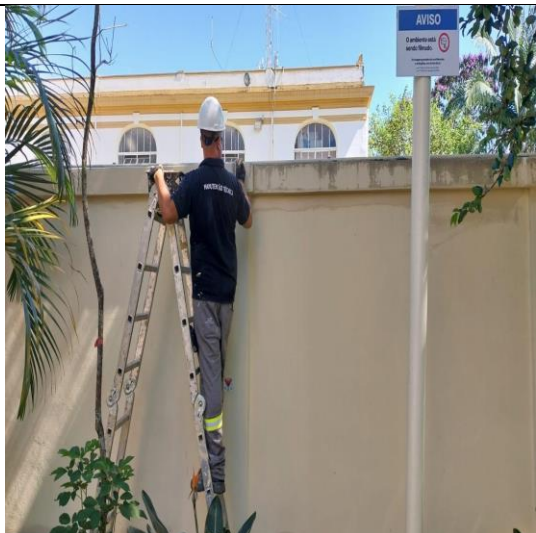
FOTO 17: Conservação dos muros perimetrais.
