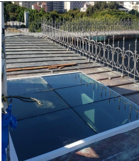
FOTO 118: Conservação cobertura, manutenção claraboia.
