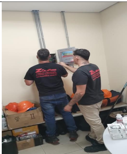
FOTO 30: Manutenção sistema de prevenção ao incêndio.
