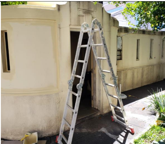
FOTO 09: Conservação dos muros perimetrais.
