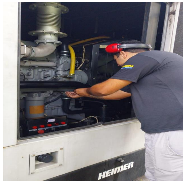
FOTO 32: Manutenção grupo motor gerador de emergência.
