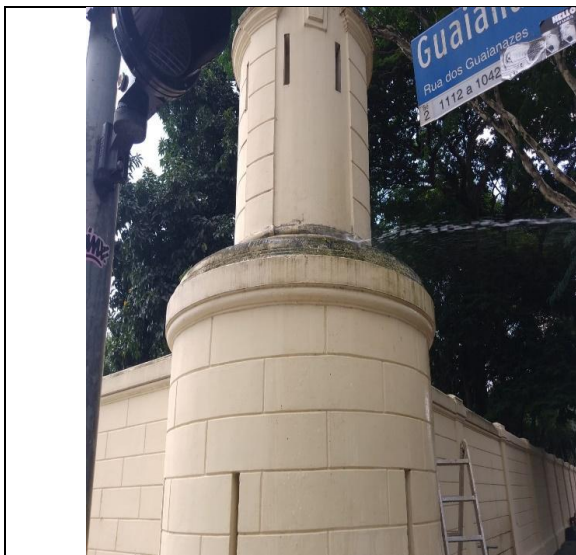
FOTO 21: Conservação dos muros perimetrais.
