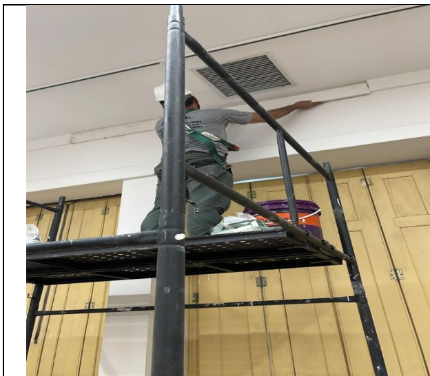
FOTO 85: Manutenção corretiva da moldura de gesso da sala expositiva número n° 01.
