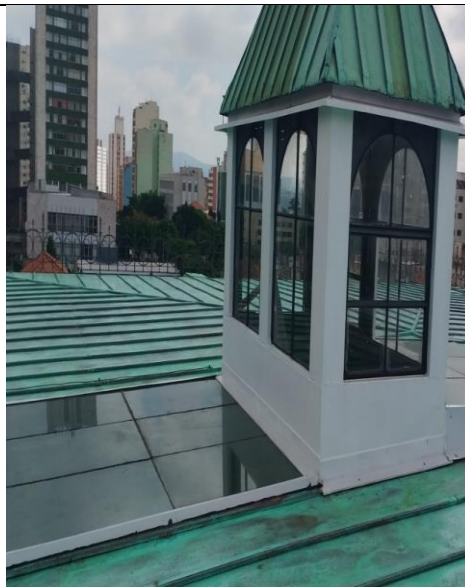
FOTO 142: Conservação cobertura, aplicação de acabamento de pátina artificial.
