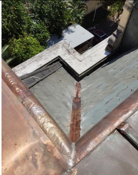
FOTO 132: Conservação cobertura, revisão de calhas.
