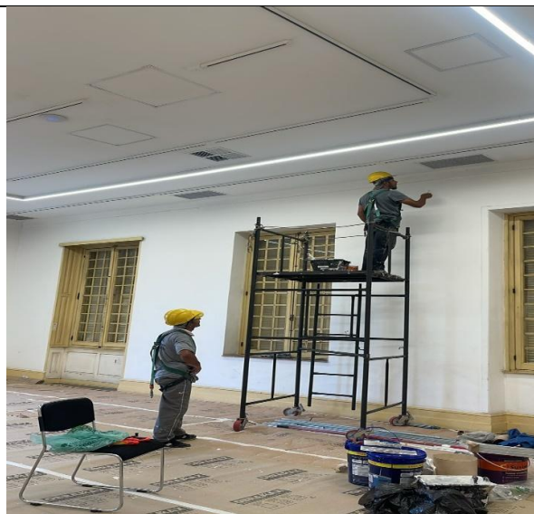
FOTO 86: Conservação do forro das salas expositivas do primeiro andar.
