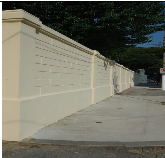
FOTO 02: Conservação dos muros perimetrais.
