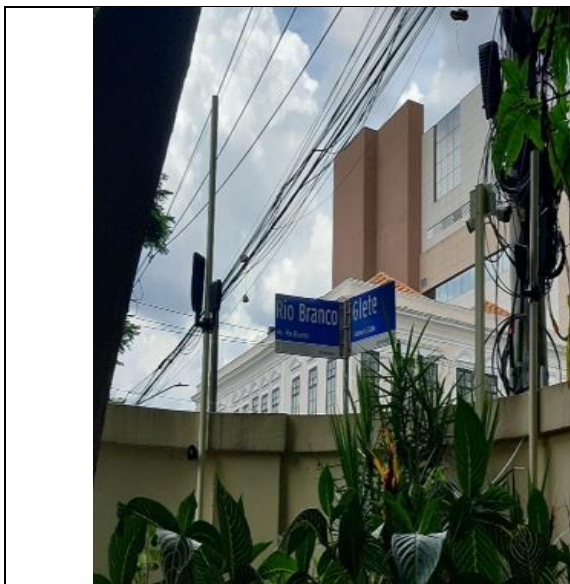
FOTO 81: Implantação de sistema de barreira eletrônica para monitoramento do perímetro.
