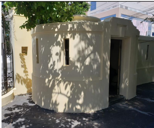
FOTO 10: Conservação dos muros perimetrais.
