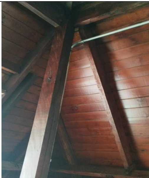
FOTO 98: Conservação cobertura, tratamento madeiramento.
