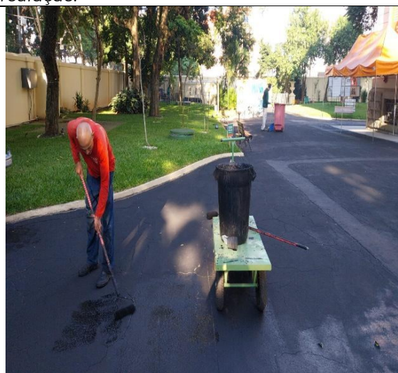
FOTO 103: Conservação piso externo de circulação.
