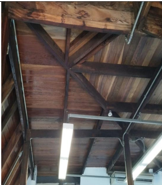
FOTO 97: Conservação cobertura, tratamento madeiramento.
