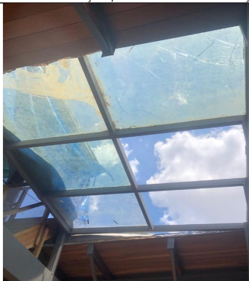
FOTO 112: Conservação cobertura, manutenção claraboia.
