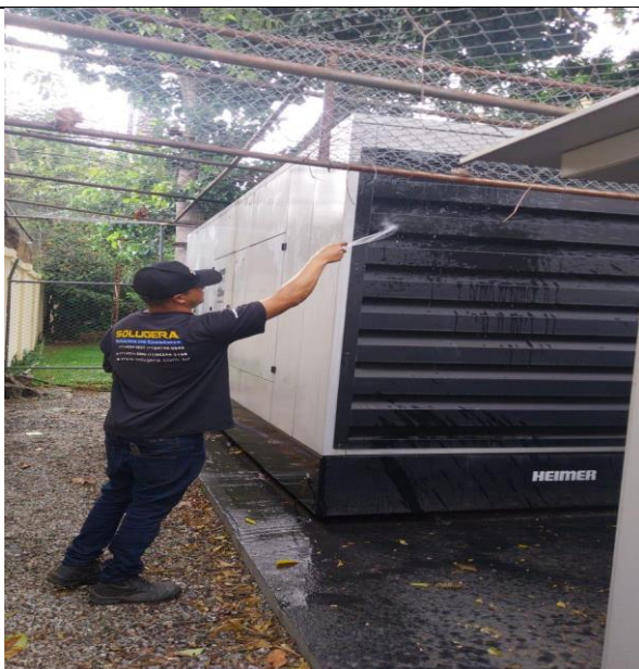
FOTO 31: Manutenção grupo motor gerador de emergência.
