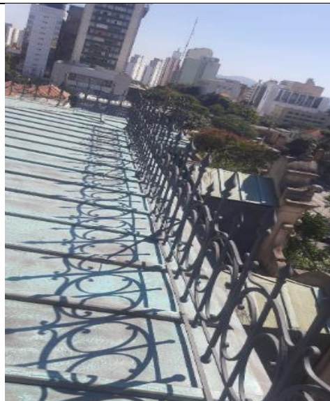
FOTO 146: Conservação cobertura, aplicação de acabamento de pátina artificial.
