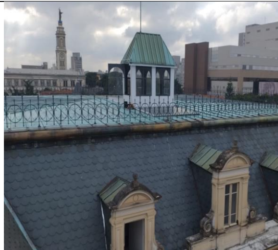
FOTO 138: Conservação cobertura reinstalação gradil e revisão ardósia.
