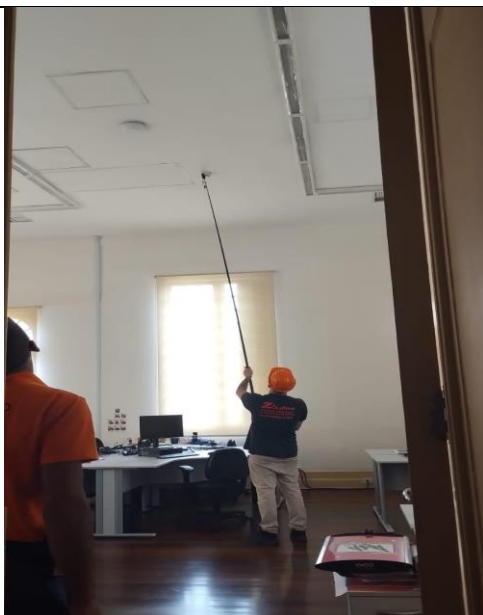
FOTO 29: Manutenção sistema de prevenção ao incêndio.
