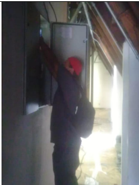
FOTO 40: Manutenção dos elevadores verticais e plataforma acessível.
