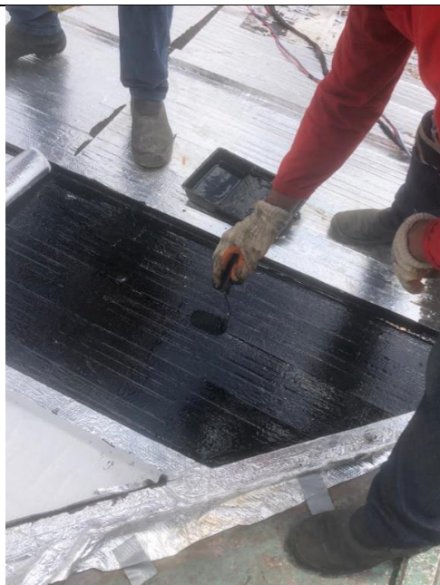
FOTO 124: Conservação cobertura, aplicação de manta térmica.
