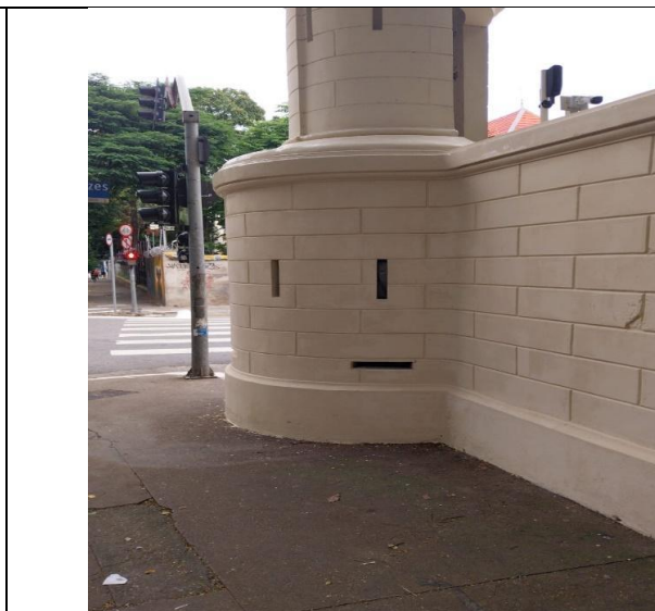
FOTO 22: Conservação dos muros perimetrais.
