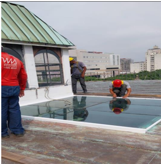
FOTO 117: Conservação cobertura, manutenção claraboia.
