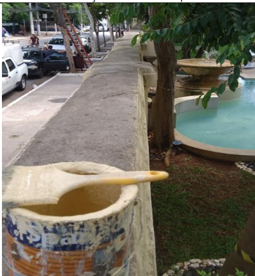
FOTO 11: Conservação dos muros perimetrais.
