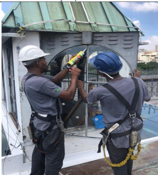
FOTO 111: Conservação cobertura, manutenção claraboia.
