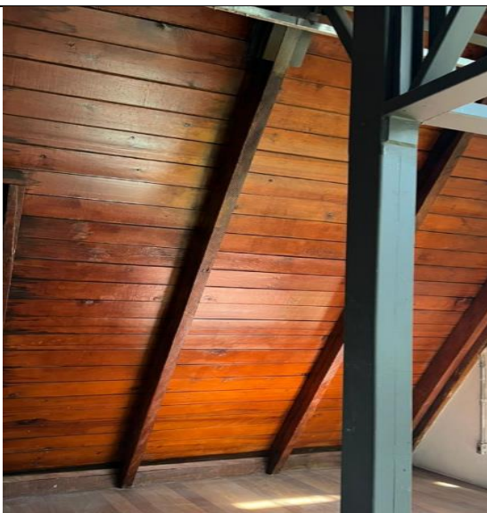
FOTO 96: Conservação cobertura, tratamento madeiramento.
