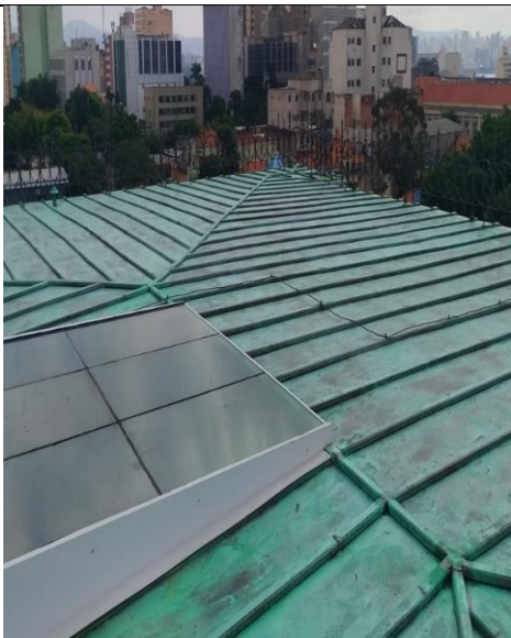
FOTO 141: Conservação cobertura, aplicação de acabamento de pátina artificial.
