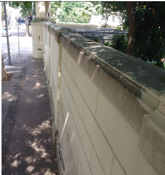
FOTO 03: Conservação dos muros perimetrais.
