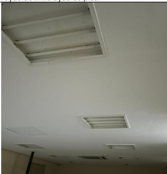
FOTO 48: Conservação do forro da sala das pias do pavimento inferior, refazimento do forro de drywall.
