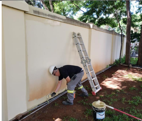
FOTO 07: Conservação dos muros perimetrais.
