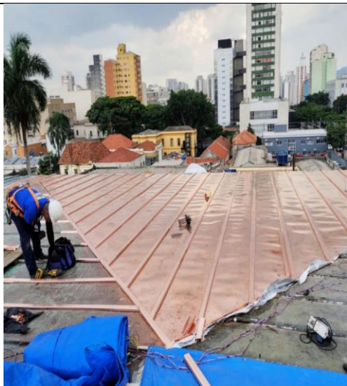
FOTO 125: Conservação cobertura, aplicação de novas telhas em cobre.
