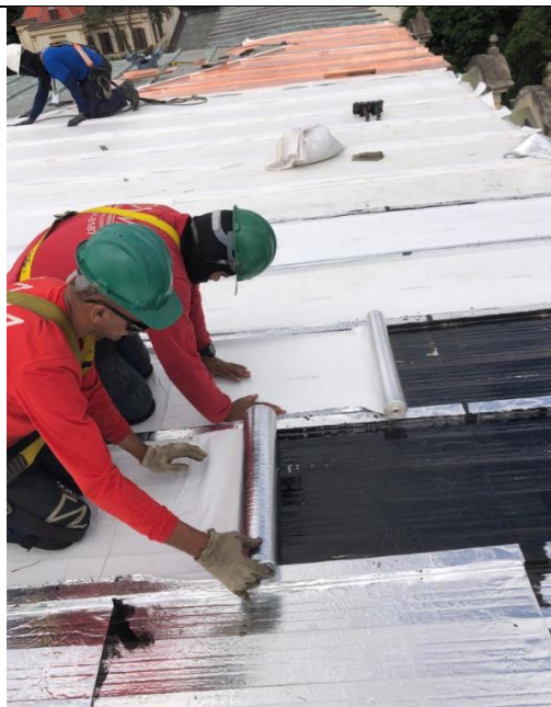
FOTO 123: Conservação cobertura, aplicação de manta térmica.
