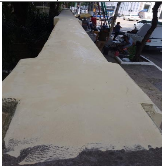
FOTO 12: Conservação dos muros perimetrais.
