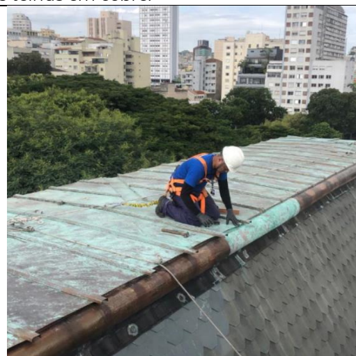
FOTO 128: Conservação cobertura, aplicação de novas telhas em cobre.
