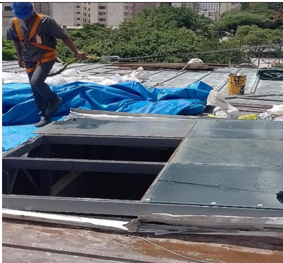
FOTO 113: Conservação cobertura, manutenção claraboia.
