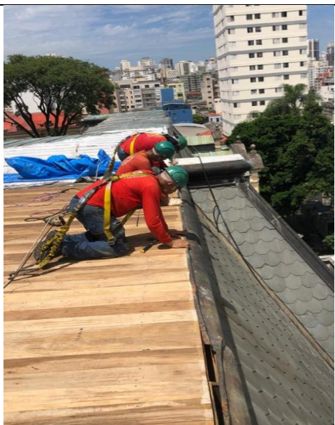
FOTO 121: Conservação cobertura, substituição de assoalho.
