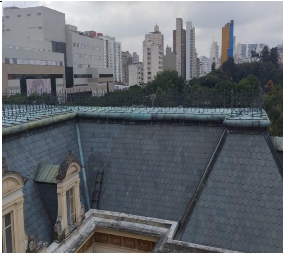
FOTO 137: Conservação cobertura reinstalação gradil.
