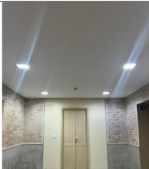
FOTO 54: Conservação civil pavimento inferior
