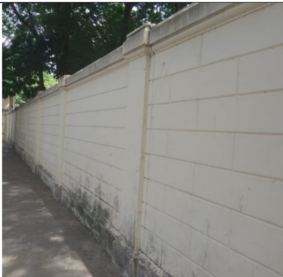
FOTO 01: Conservação dos muros perimetrais.
