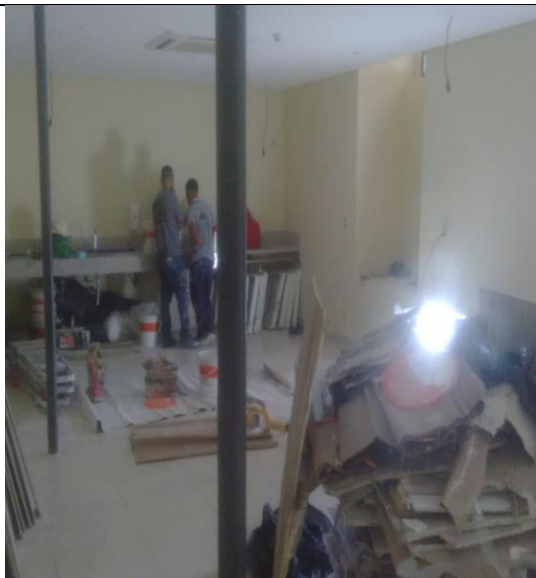
FOTO 49: Conservação do forro da sala das pias do pavimento inferior, refazimento do forro de drywall.
