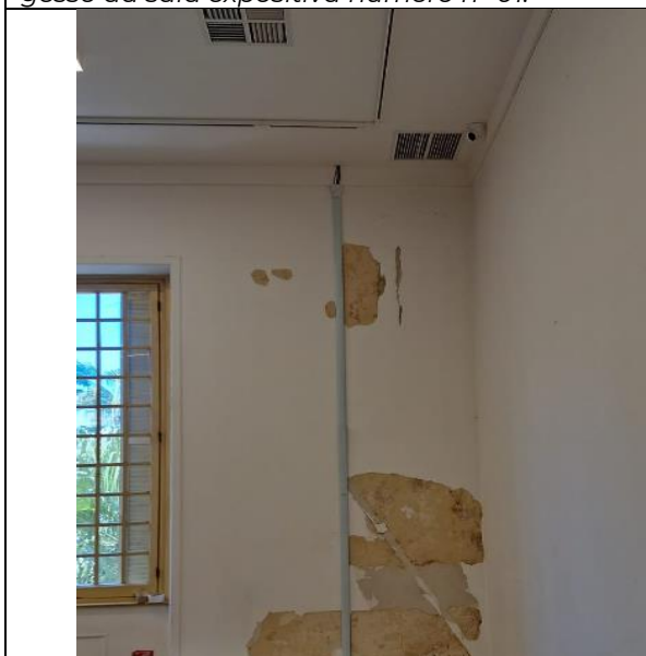
FOTO 87: Manutenção corretiva de ponto de infiltração da sala expositiva n° 03.
