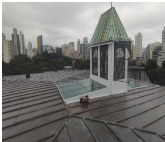
FOTO 139: Conservação cobertura reinstalação gradil.
