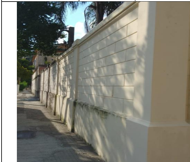
FOTO 23: Conservação dos muros perimetrais.
