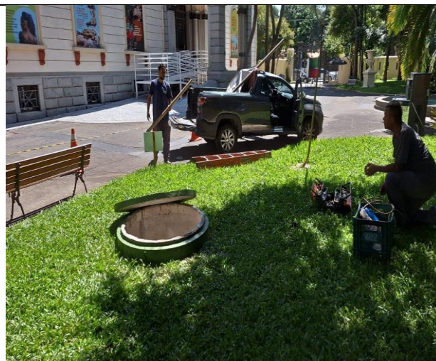
FOTO 42: Manutenção corretiva hidráulica do sistema de drenagem externa.
