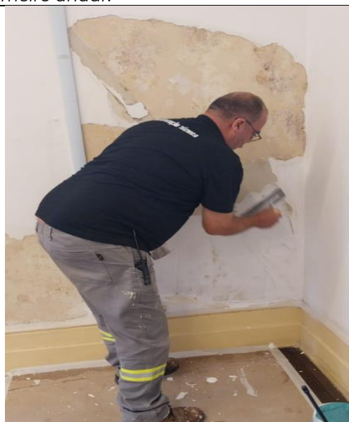
FOTO 88: Manutenção corretiva de ponto de infiltração da sala expositiva n° 03.
