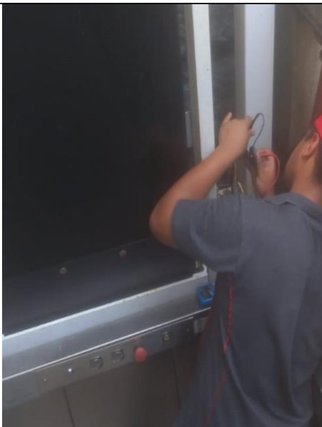
FOTO 39: Manutenção dos elevadores verticais e plataforma acessível.
