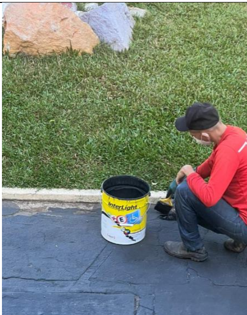
FOTO 109: Conservação piso externo de circulação.
