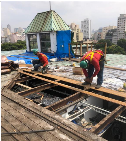
FOTO 119: Conservação cobertura, substituição assoalho.
