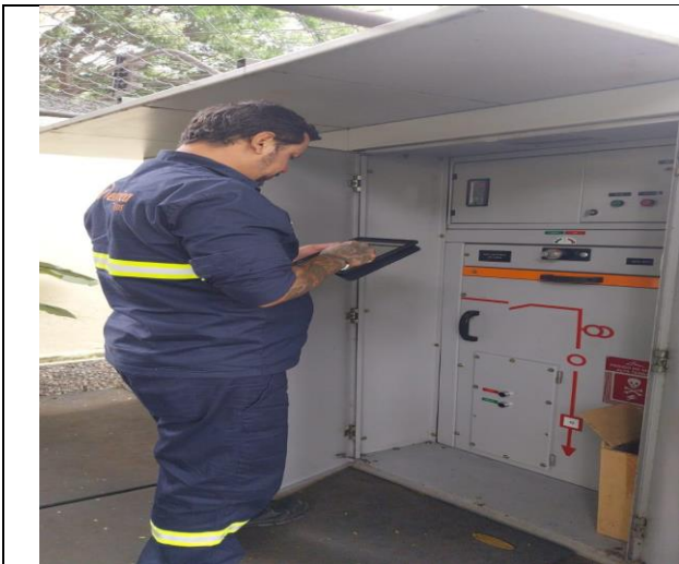
FOTO 33: Manutenção da entrada de energia elétrica.
