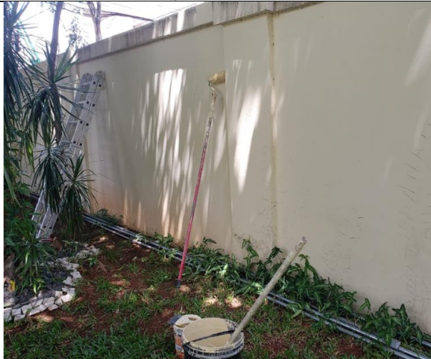
FOTO 08: Conservação dos muros perimetrais.
