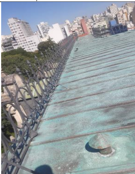
FOTO 143: Conservação cobertura, aplicação de acabamento de pátina artificial.
