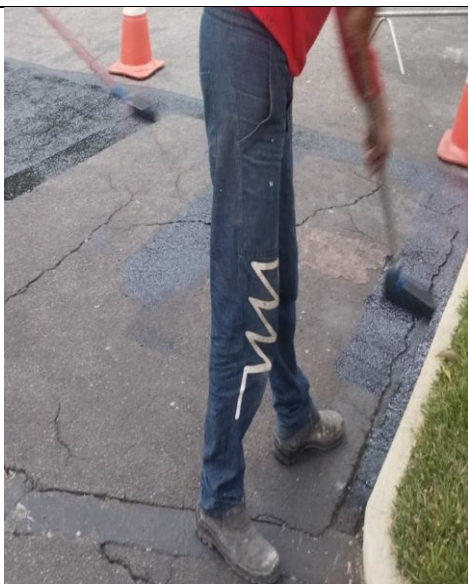
FOTO 105: Conservação piso externo de circulação.
