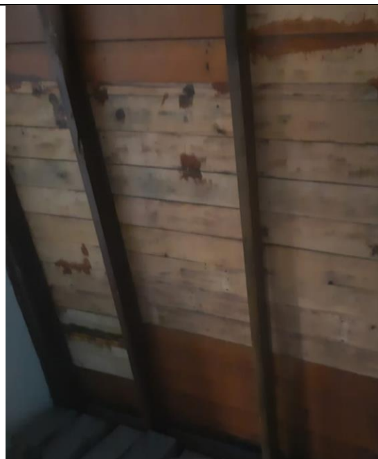
FOTO 94: Conservação cobertura, tratamento madeiramento.
