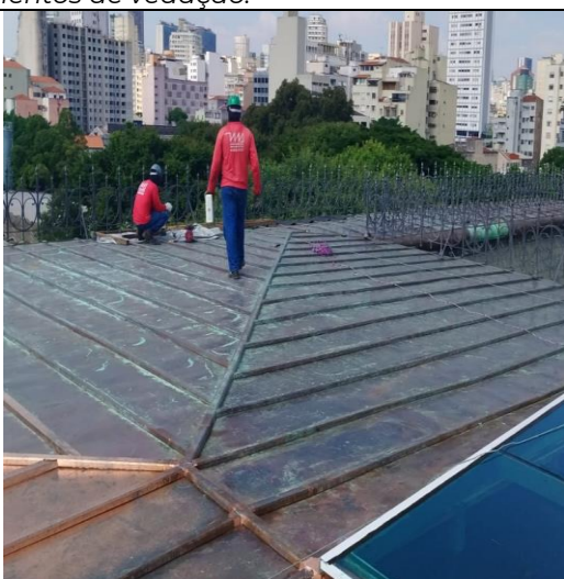
FOTO 135: Conservação cobertura reinstalação gradil.
