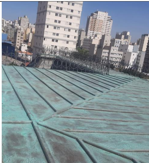
FOTO 150: Conservação cobertura, aplicação de acabamento de pátina artificial.
