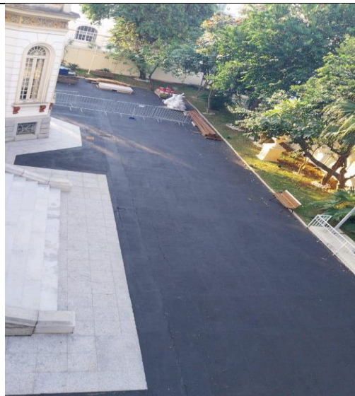
FOTO 102: Conservação piso externo de circulação.
