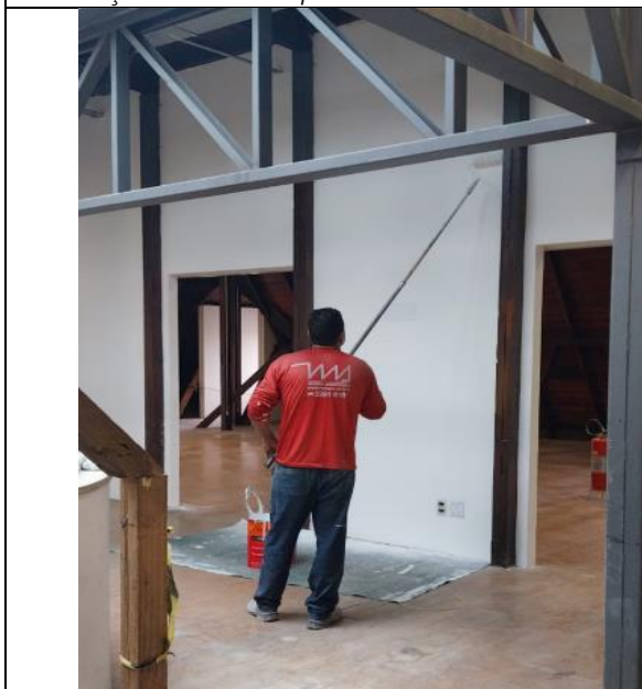
FOTO 91: Conservação das paredes do pavimento ático.
