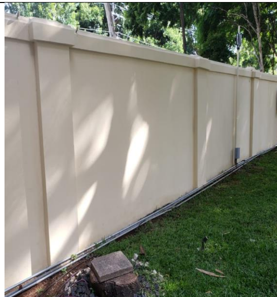
FOTO 14: Conservação dos muros perimetrais.
