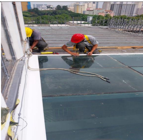
FOTO 115: Conservação cobertura, manutenção claraboia.
