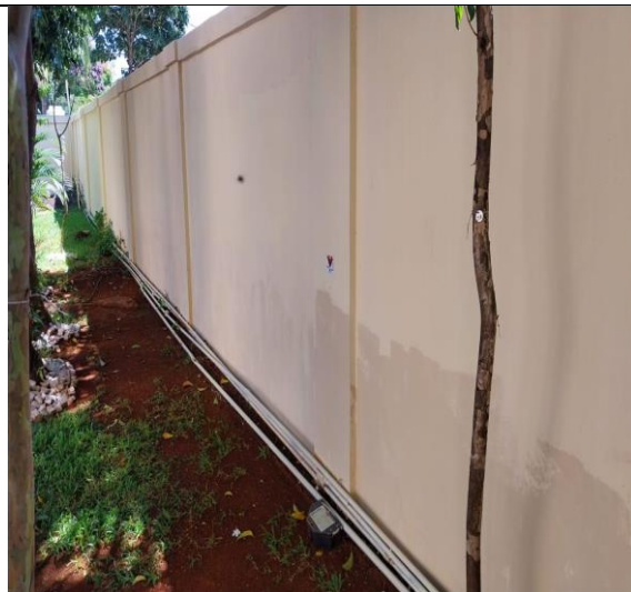
FOTO 18: Conservação dos muros perimetrais.
