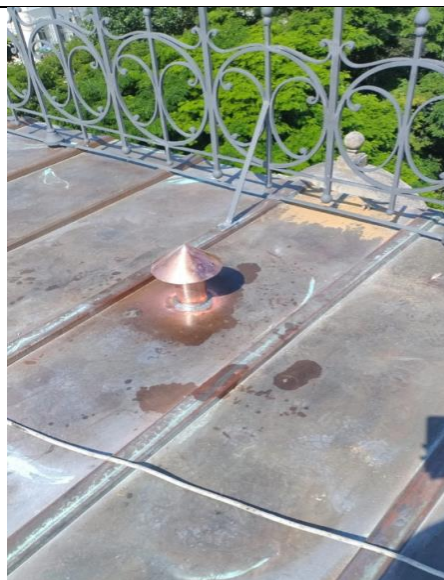
FOTO 134: Conservação cobertura, fechamento elementos de vedação.
