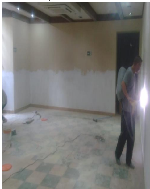
FOTO 51: Conservação civil pavimento inferior
