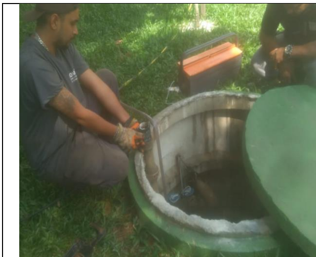
FOTO 41: Manutenção corretiva hidráulica do sistema de drenagem externa.
