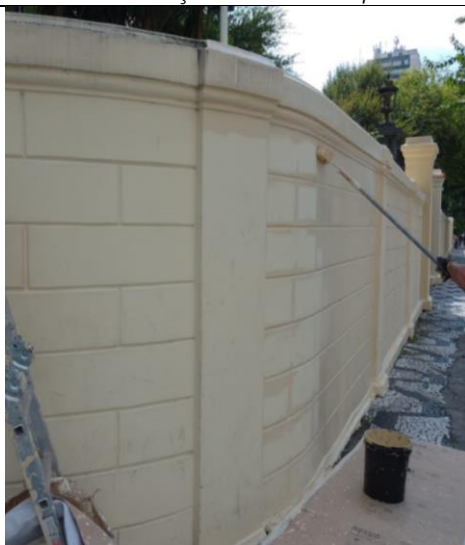
FOTO 15: Conservação dos muros perimetrais.
