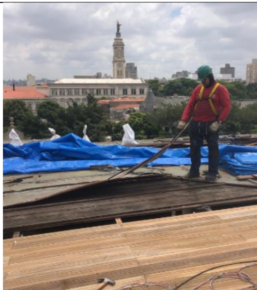
FOTO 120: Conservação cobertura, substituição assoalho.
