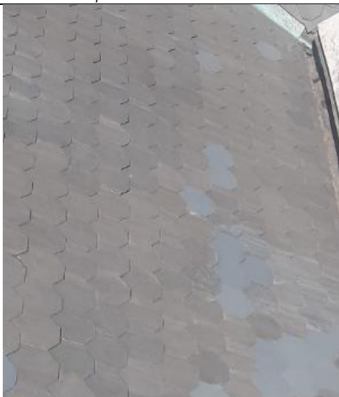
FOTO 147: Conservação cobertura, manutenção do fechamento de ardósia.
