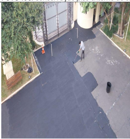
FOTO 108: Conservação piso externo de circulação.
