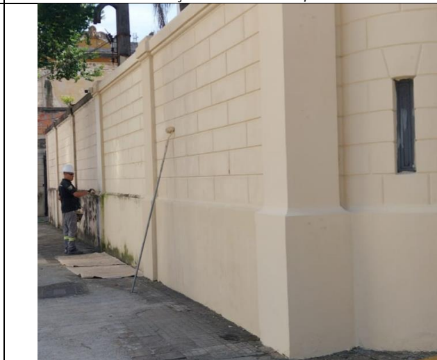
FOTO 24: Conservação dos muros perimetrais.
