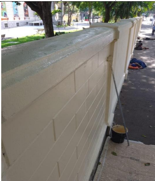
FOTO 04: Conservação dos muros perimetrais.
