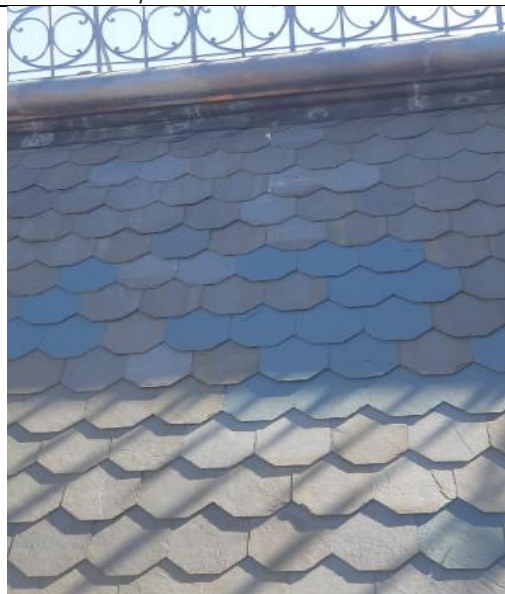
FOTO 152: Conservação cobertura, manutenção e fechamento de ardósia.
