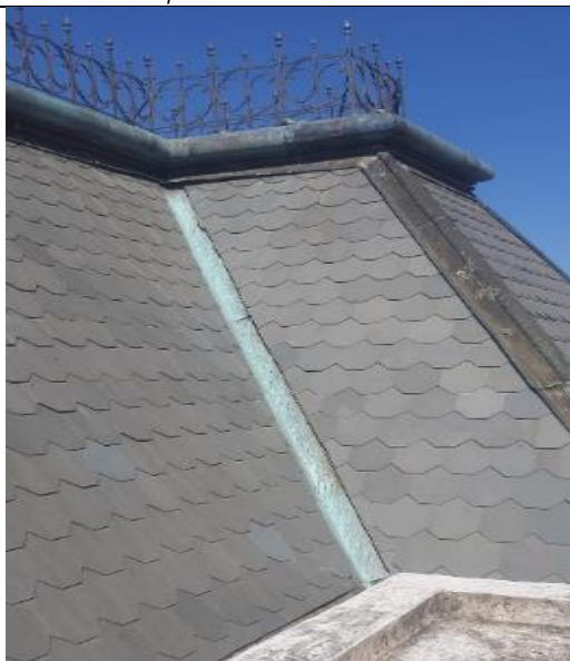
FOTO 151: Conservação cobertura, manutenção fechamento de ardósia.
