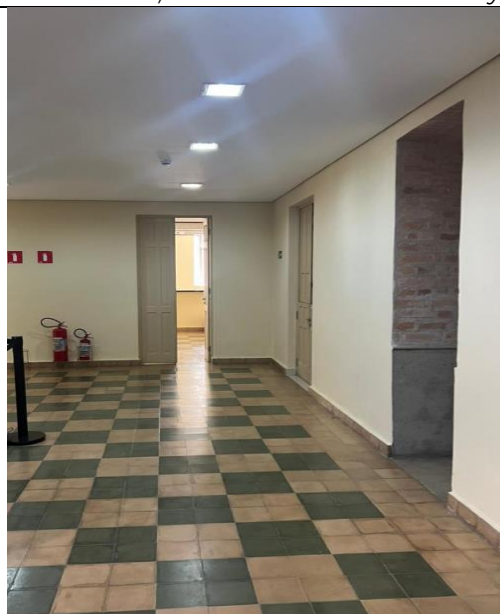
FOTO 52: Conservação civil pavimento inferior
