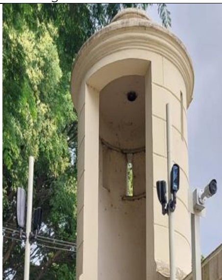
FOTO 80: Implantação de sistema de barreira eletrônica para monitoramento do perímetro.
