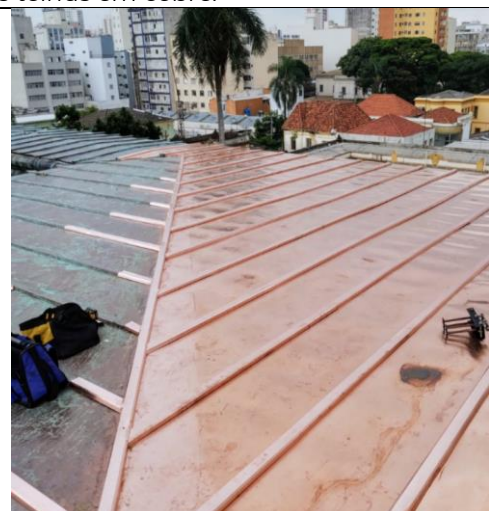
FOTO 127: Conservação cobertura, aplicação de novas telhas em cobre.
