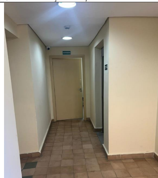
FOTO 56: Conservação civil pavimento inferior
