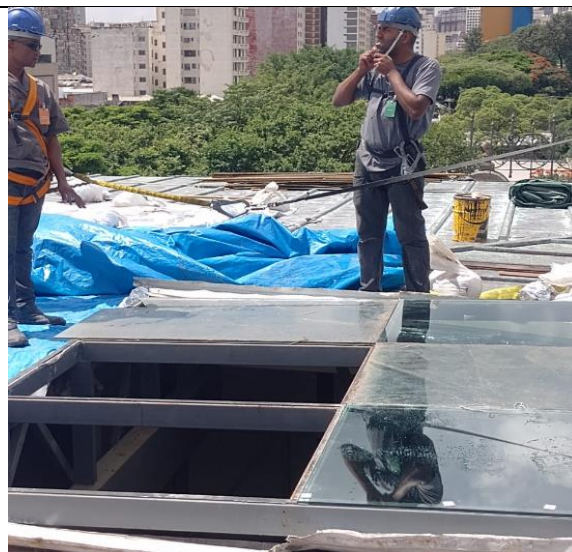
FOTO 116: Conservação cobertura, manutenção claraboia.
