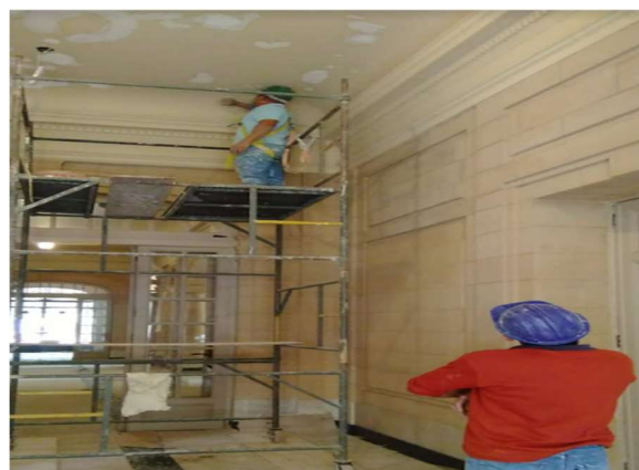
FOTO 6: Conservação forro hall, pavimento térreo.
