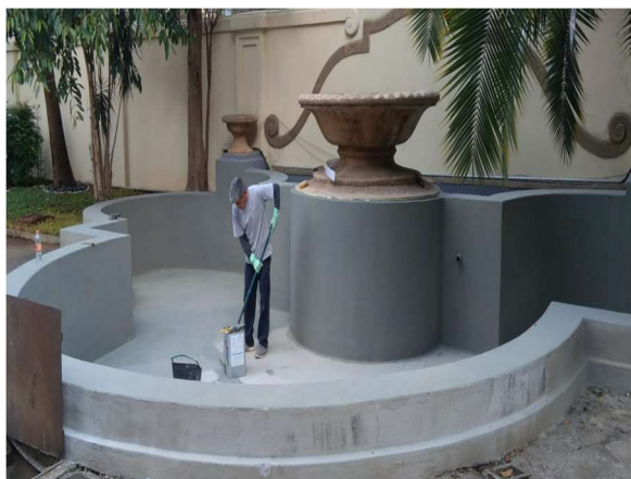
FOTO 63: Recuperação e operação chafariz, impermeabilização.
