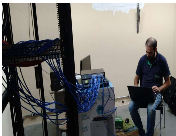
FOTO 71: Implantação CFTV, switch CPD.
