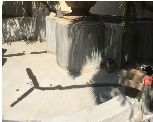
FOTO 62: Recuperação e operação chafariz, reparação.
