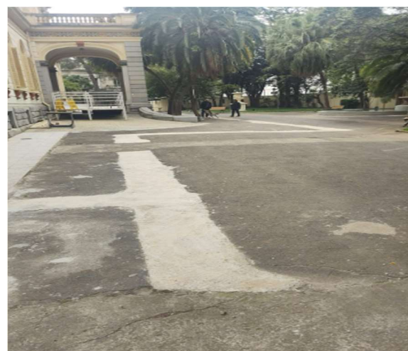
FOTO 103: Conservação revestimento externo de circulação, revestimento com elemento de demarcação, pintura e correção viária.
