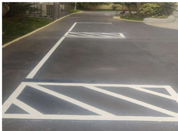
FOTO 109: Implantação de vagas acessíveis.
