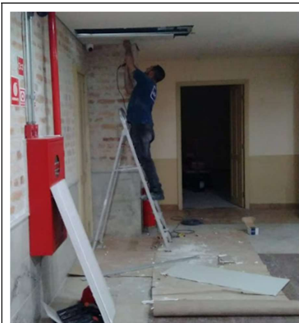
FOTO 57: Adequação forro dry wall hall banheiros pavimento inferior.
