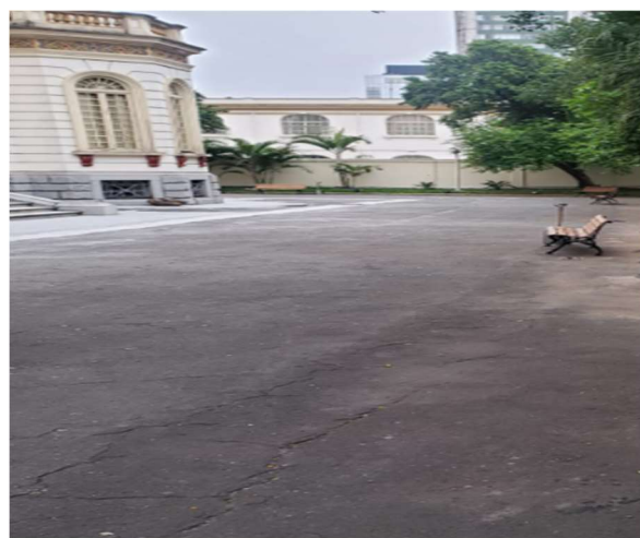
FOTO 104: Conservação revestimento externo de circulação, revestimento com elemento de demarcação, pintura e correção viária.
