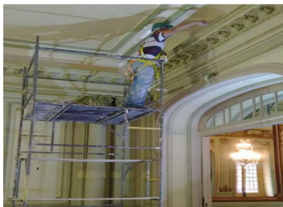
FOTO 7: Conservação forro hall, pavimento térreo
