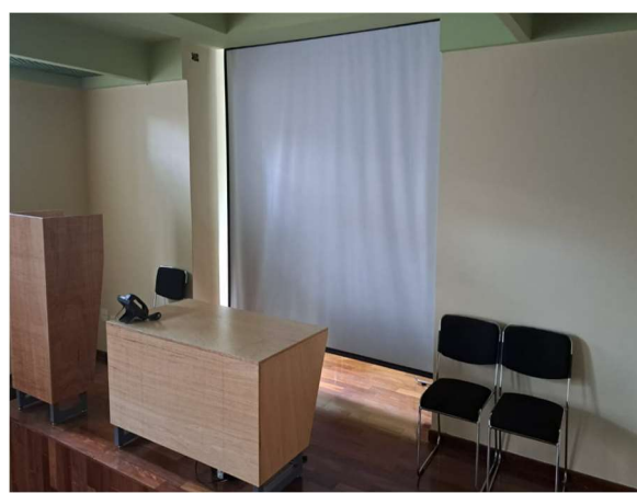
FOTO 86: Manutenção corretiva revestimento paredes auditório.
