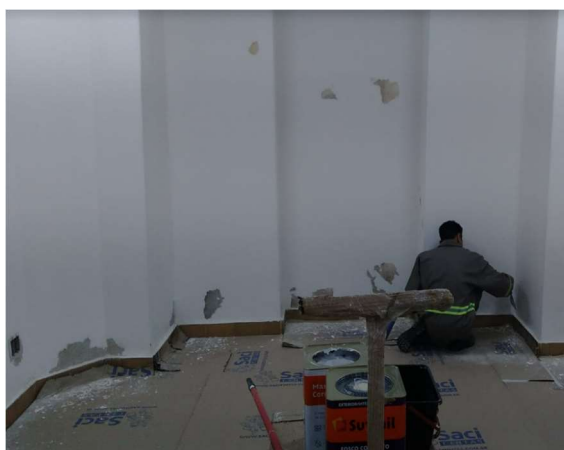
FOTO 85: Manutenção corretiva revestimento paredes auditório, apoio.
