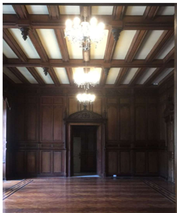
FOTO 9: Conservação sala futura loja, térreo.
