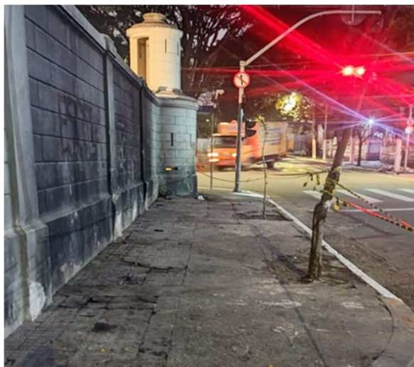
FOTO 19: Conservação muros perimetrais, Rua Guaianazes, antigo ponto de descarte de resíduos.
