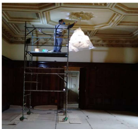
FOTO 5: Conservação forro sala de múltiplo uso nº 1, pavimento térreo, reparação.
