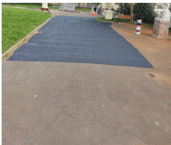
FOTO 101: Conservação revestimento externo de circulação, revestimento com elemento de demarcação, pintura e correção viária.
