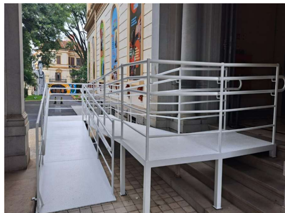
FOTO 110: Pintura e conservação da rampa acessível lateral.
