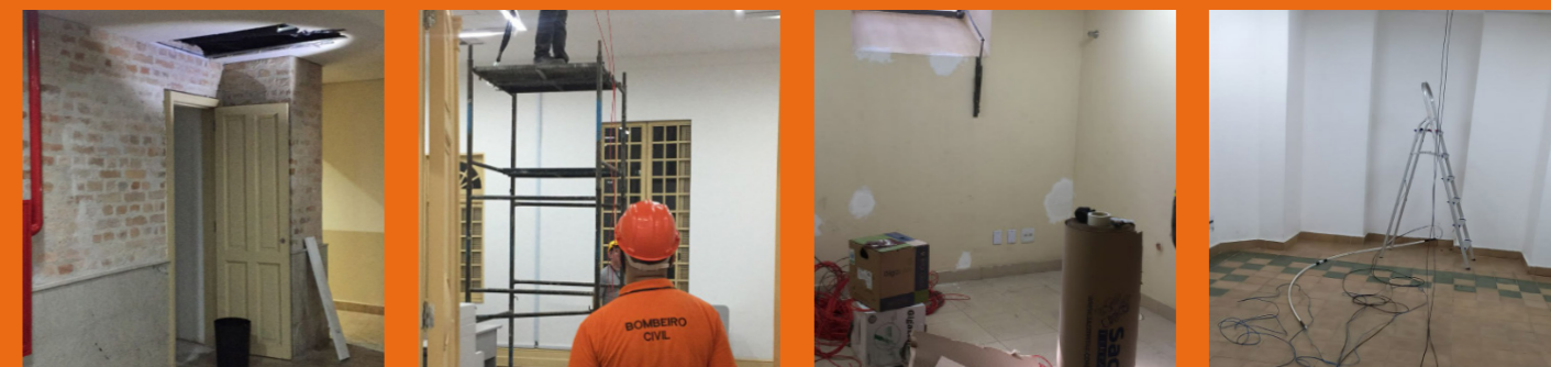
Implantação e rede Wireless no primeiro pavimento e pavimento inferior, salas de trabalho. manutenção da tubulação de água dos hidrantes do térreo.
