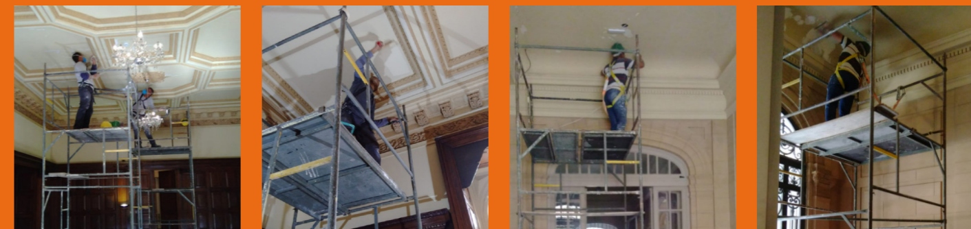
Atividade de conservação do forro do hall principal, corredor do térreo e salas de múltiplo uso.
