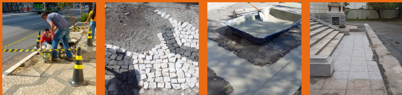
Conservação da calçada frontal da Avenida Rio Branco e higienização dos pisos, granito externo/ escadaria.
