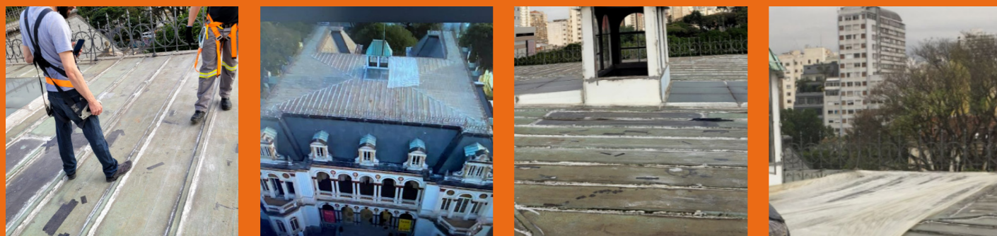
Isolamento emergencial da cobertura, devido aos pontos de infiltração, localizado nas salas de máquina dos elevadores.
