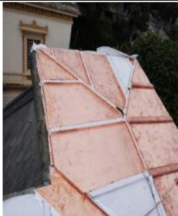
FOTO 135: Atividade de conservação da cobertura, instalação da manta de subcobertura térmica, conforme orientações do IPT quanto ao contato entre metais (Cobre e alumínio).
