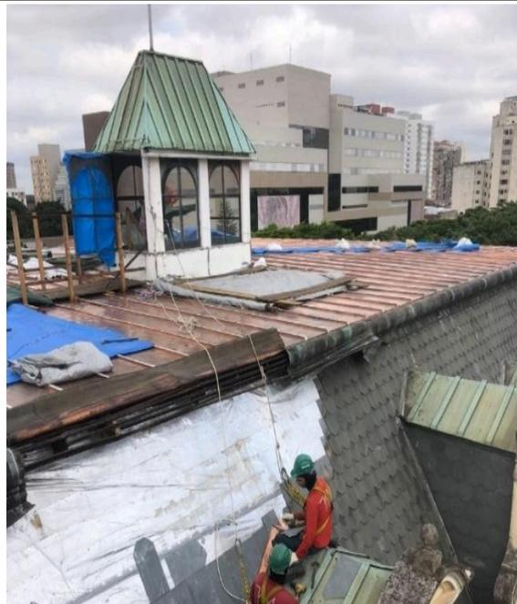
FOTO 154: Conservação da cobertura, início da revisão do fechamento lateral dos cortes acabados em ardósia, revisão da manta de subcobertura.
