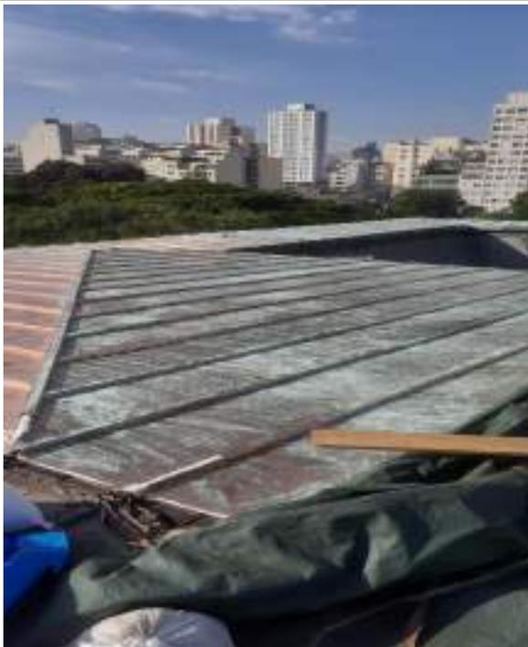
FOTO 151: Conservação da cobertura, aplicação para acabamento do cobre, processo de pátina induzida artificial.
