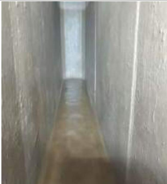
FOTO 119: Atividade de conservação para limpeza e desinfecção dos reservatórios de água potável, águas pluviais e esgoto.
