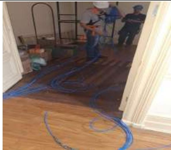
FOTO 38: Instalação de infraestrutura para CFTV, Rede Wireless e ponto cabeado para lógica das mostras a serem instaladas nos ambientes das salas expositivas do primeiro pavimento.
