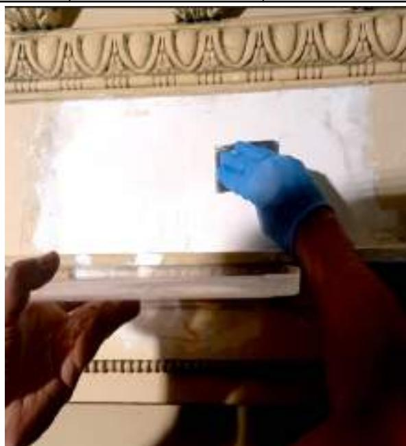
FOTO 84: Atividade de conservação na moldura da sala de múltiplo uso nº 3 (Correção do acesso técnico para estruturas do forro).
