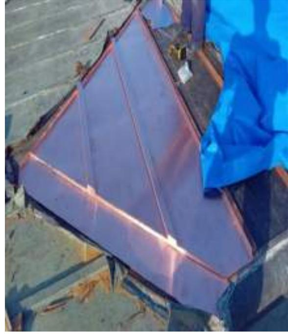
FOTO 130: Atividade de conservação da cobertura, adequação do assoalho e instalação das telhas e caibros em cobre.
