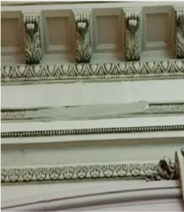
FOTO 76: Atividade de conservação na moldura da sala de múltiplo uso nº 3 (Correção do acesso técnico para estruturas do forro).
