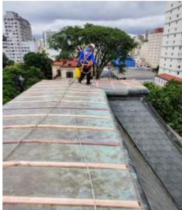
FOTO 142: Conservação da cobertura, aplicação para acabamento do cobre, processo de pátina induzida artificial.
