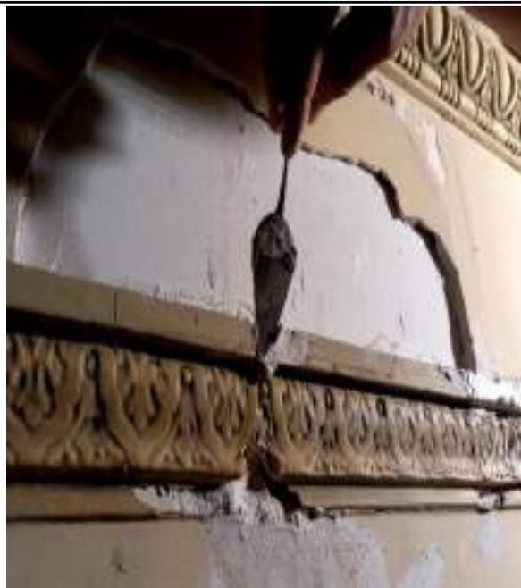
FOTO 82: Atividade de conservação na moldura da sala de múltiplo uso nº 3 (Correção do acesso técnico para estruturas do forro).
