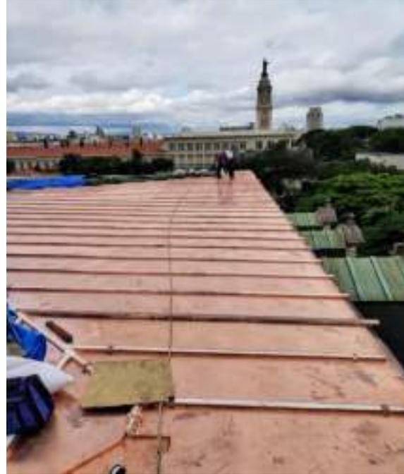
FOTO 150: Conservação da cobertura, instalação de revestimento e alinhamento do caimento das águas da coberta.
