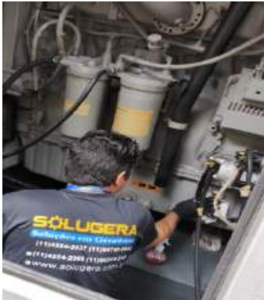
FOTO 73: Manutenção do grupo motogerador de emergência, adequação do painel e troca de baterias.
