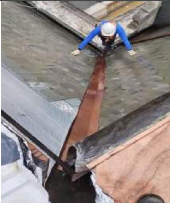
FOTO 145: Conservação da cobertura, revisão dos elementos do sistema de água pluvial.
