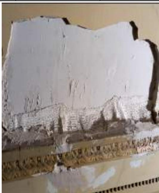
FOTO 83: Atividade de conservação na moldura da sala de múltiplo uso nº 3 (Correção do acesso técnico para estruturas do forro).
