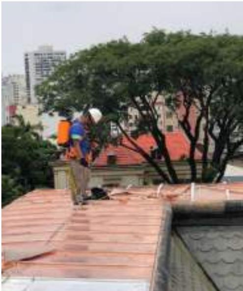
FOTO 139: Atividade de conservação da cobertura, instalação da manta de subcobertura térmica, conforme orientações do IPT quanto ao contato entre metais (Cobre e alumínio).
