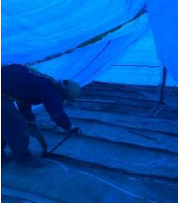
FOTO 133: Atividade de conservação da cobertura, remoção das telhas e estrutura danificada.
