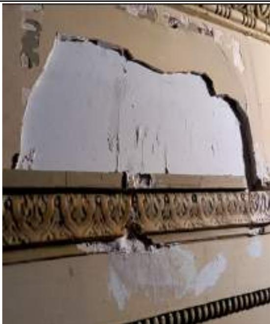
FOTO 81: Atividade de conservação na moldura da sala de múltiplo uso nº 3 (Correção do acesso técnico para estruturas do forro).
