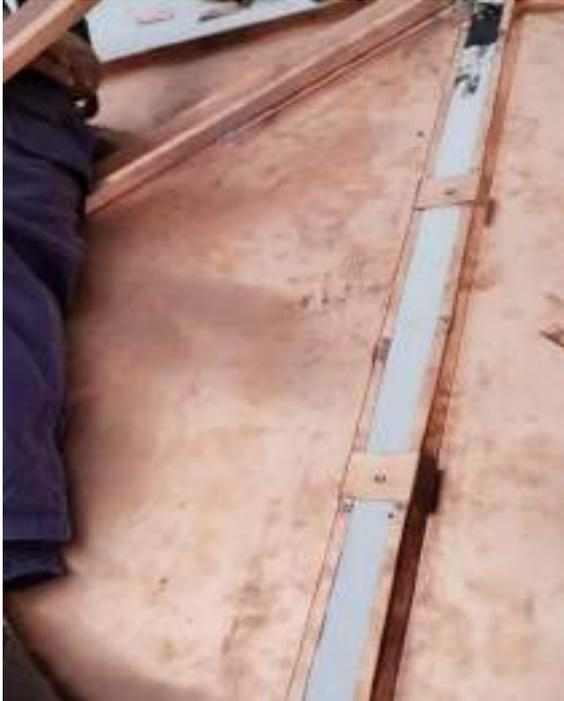
FOTO 137: Atividade de conservação da cobertura, instalação da manta de subcobertura térmica, conforme orientações do IPT quanto ao contato entre metais (Cobre e alumínio).
