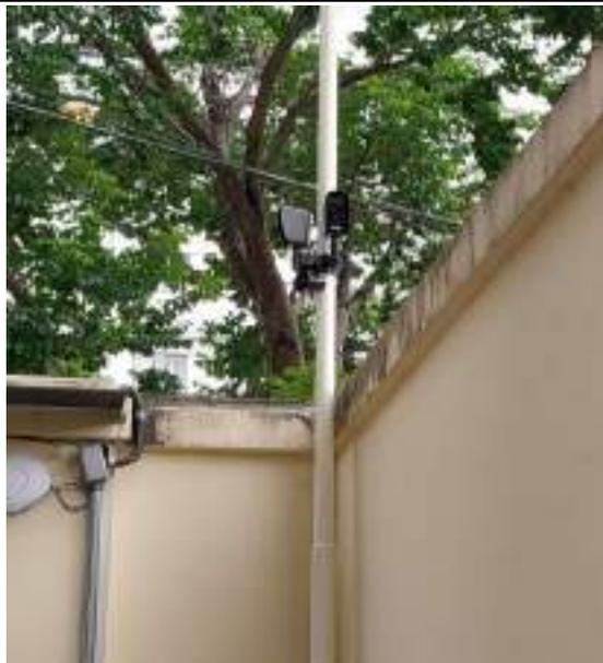
FOTO 101: Implantação de sistema para monitoramento autônomo perimetral das 4 fachadas.
