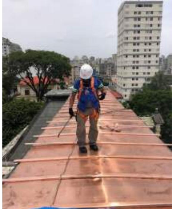
FOTO 138: Atividade de conservação da cobertura, instalação da manta de subcobertura térmica, conforme orientações do IPT quanto ao contato entre metais (Cobre e alumínio).
