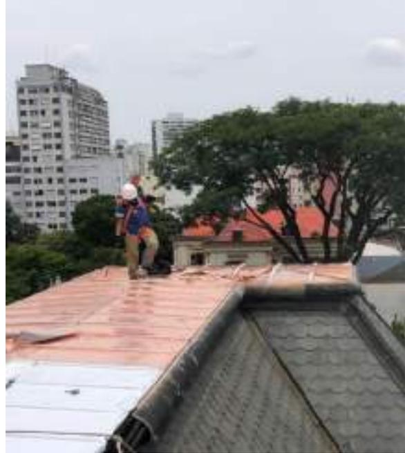
FOTO 134: Atividade de conservação da cobertura, instalação da manta de subcobertura térmica, conforme orientações do IPT quanto ao contato entre metais (Cobre e alumínio).
