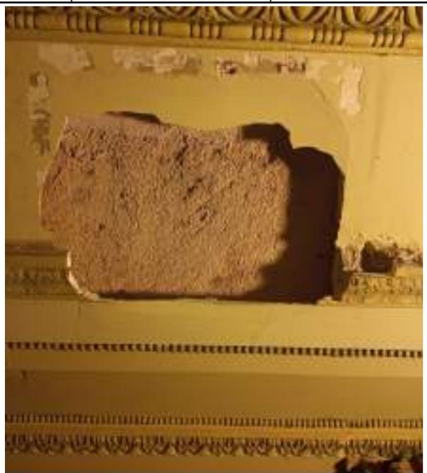
FOTO 80: Atividade de conservação na moldura da sala de múltiplo uso nº 3 (Correção do acesso técnico para estruturas do forro).
