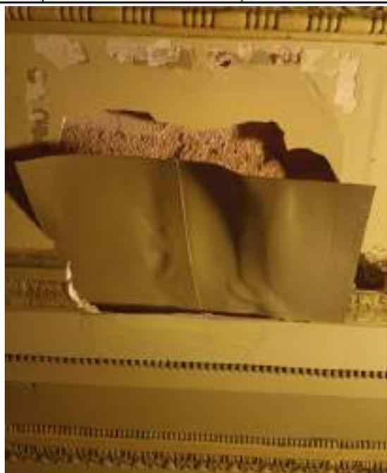
FOTO 79: Atividade de conservação na moldura da sala de múltiplo uso nº 3 (Correção do acesso técnico para estruturas do forro).
