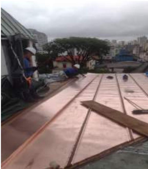
FOTO 123: Atividade de conservação da cobertura, instalação das telhas em cobre.
