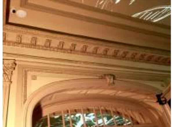
FOTO 86: Atividade de conservação na moldura da sala de múltiplo uso nº 3 (Correção do acesso técnico para estruturas do forro).
