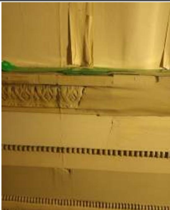
FOTO 77: Atividade de conservação na moldura da sala de múltiplo uso nº 3 (Correção do acesso técnico para estruturas do forro).
