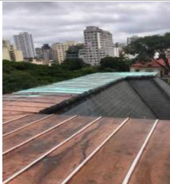
FOTO 144: Conservação da cobertura, aplicação para acabamento do cobre, processo de pátina induzida artificial.
