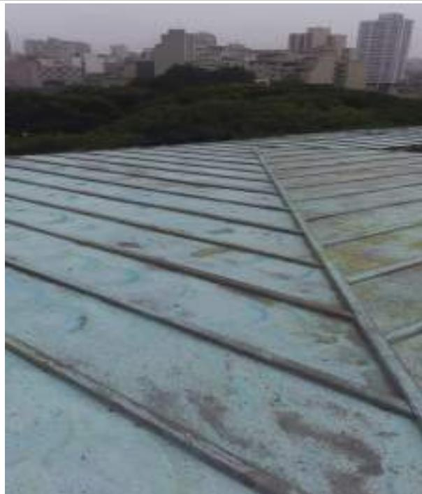
FOTO 152: Conservação da cobertura, aplicação para acabamento do cobre, processo de pátina induzida artificial.
