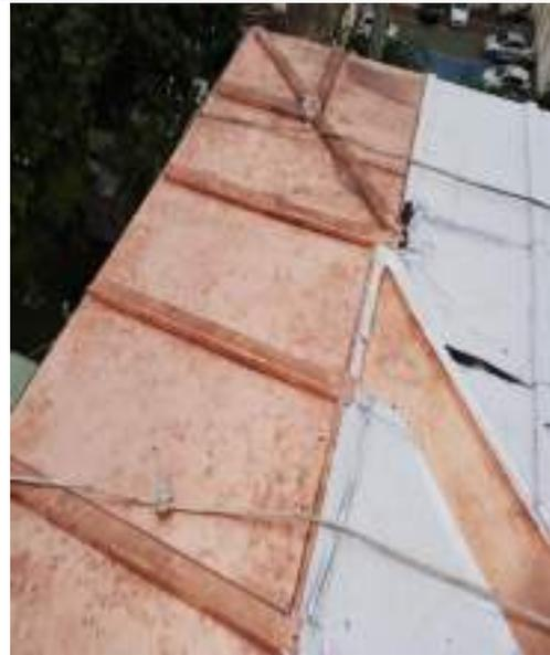
FOTO 140: Atividade de conservação da cobertura, instalação da manta de subcobertura térmica, conforme orientações do IPT quanto ao contato entre metais (Cobre e alumínio).
