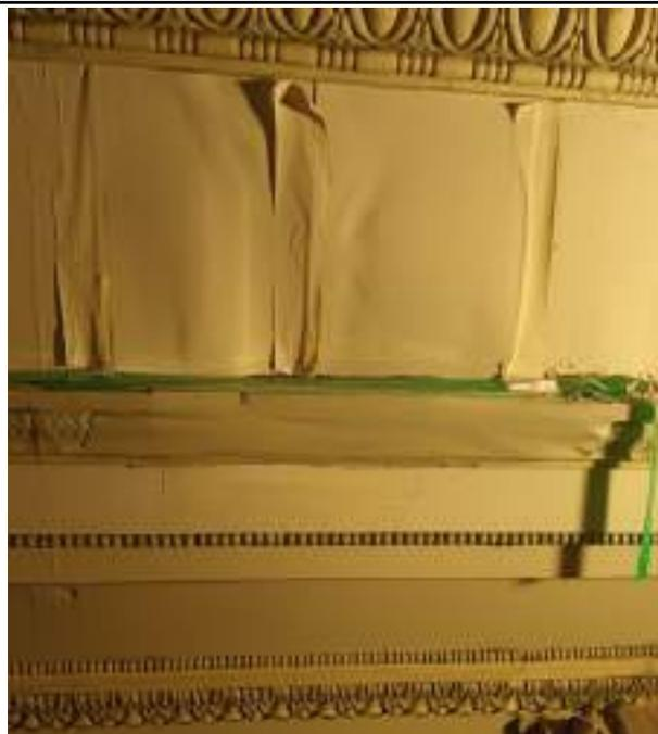
FOTO 78: Atividade de conservação na moldura da sala de múltiplo uso nº 3 (Correção do acesso técnico para estruturas do forro).
