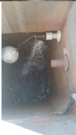
FOTO 69: Implantação: Serviço de conservação, higienização reservatórios de reserva de incêndio.
