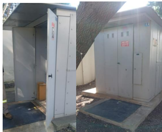
FOTO 62: Implantação: Serviço de conservação cabine primária.
