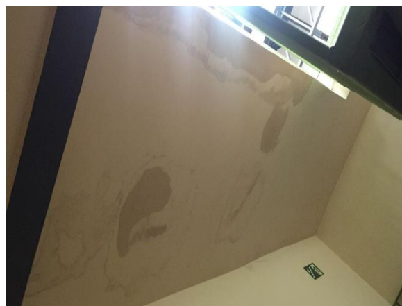
FOTO 52: Manutenção corretiva: Vedação temporária cobertura Ático, escoamento escada de acesso ao Ático.
