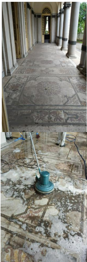
FOTO 29: Implantação: Serviço de conservação, limpeza varanda.
