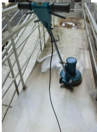
FOTO 27: Implantação: Serviço de conservação, limpeza rampa.
