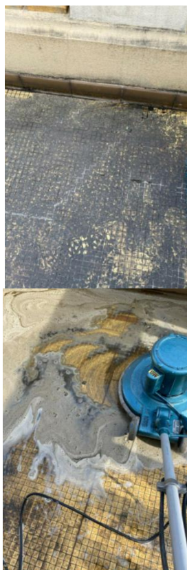
FOTO 19: Implantação: Serviço de conservação, limpeza de varandas.
