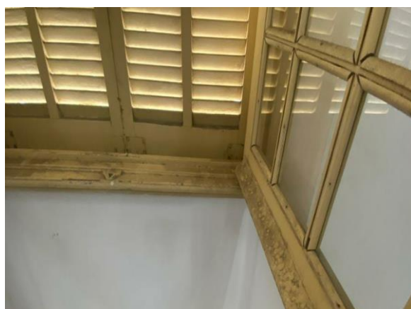
FOTO 21: Implantação: Serviço de conservação, limpeza janelas.
