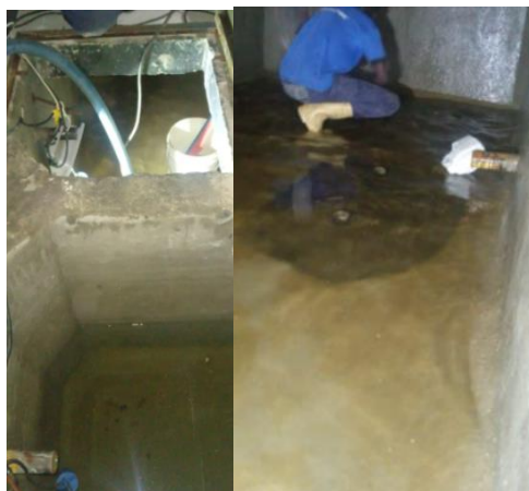
FOTO 68: Implantação: Serviço de conservação, higienização reservatórios de água potável.
