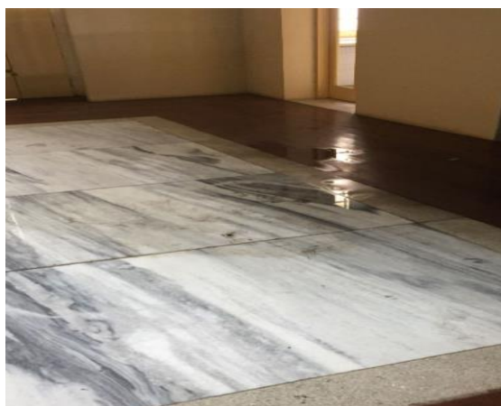
FOTO 51: Manutenção corretiva: Vedação temporária cobertura Ático, escoamento 1º andar.
