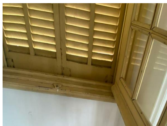
FOTO 22: Implantação: Serviço de conservação, limpeza janelas.
