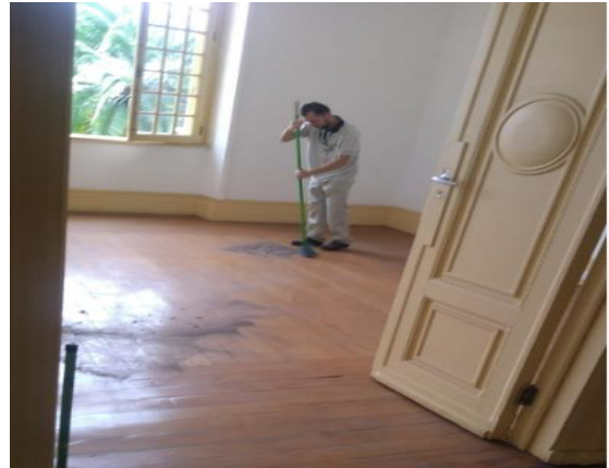
FOTO 34: Implantação: Serviço de conservação, limpeza 1º andar.
