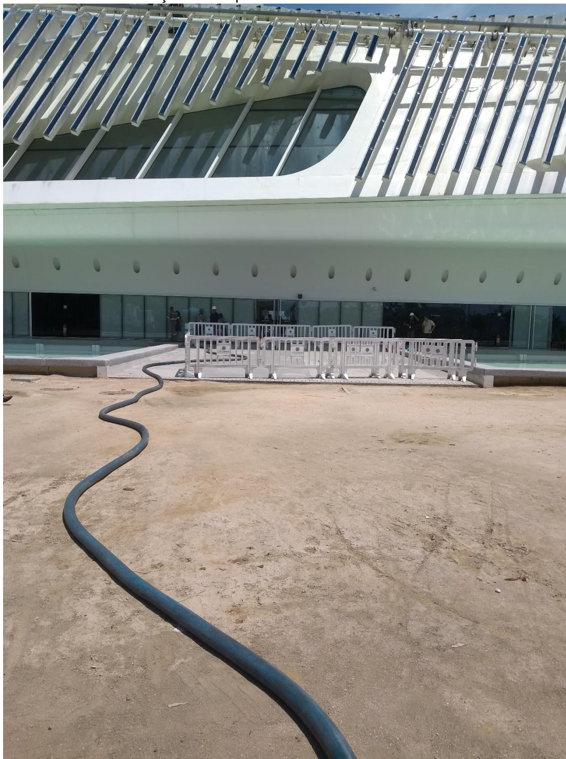
Foto 4: Área de construção de rampa.
