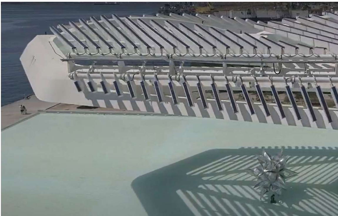
FOTO 54 – LATERAL OESTE ENTRE EIXOS G6 e G7
