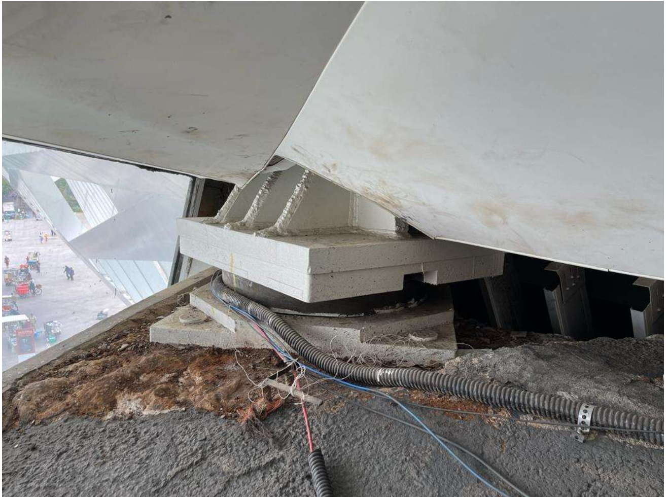
FOTO 02 – VISTA GERAL – BALANÇO TERRA APARELHOS DE APOIO
