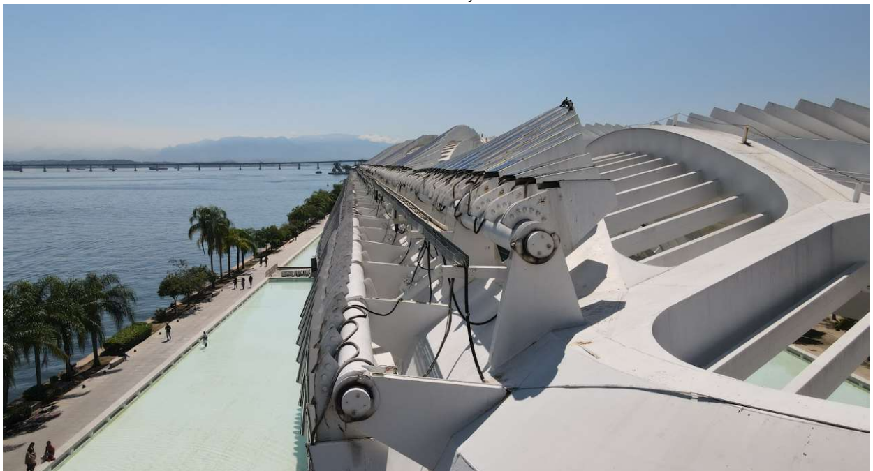
FOTO 62 – EIXOS DE MOVIMENTAÇÃO DAS ALETAS OESTE
