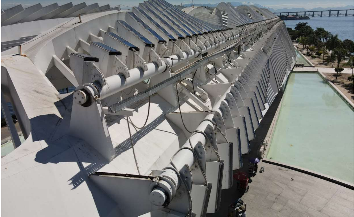
FOTO 63 – EIXOS DE MOVIMENTAÇÃO DAS ALETAS LESTE
