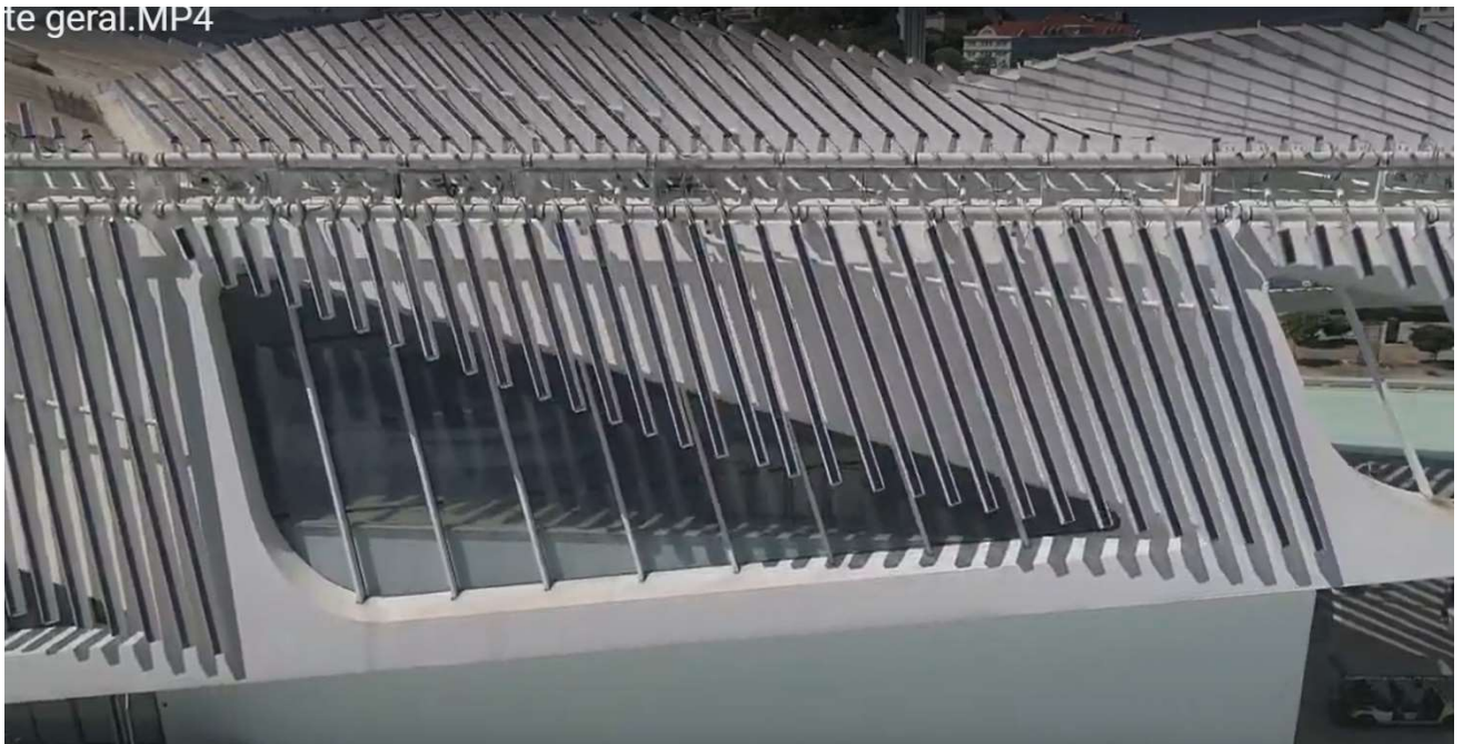
FOTO 46 – LATERAL OESTE ENTRE EIXOS G-3 e G-2
