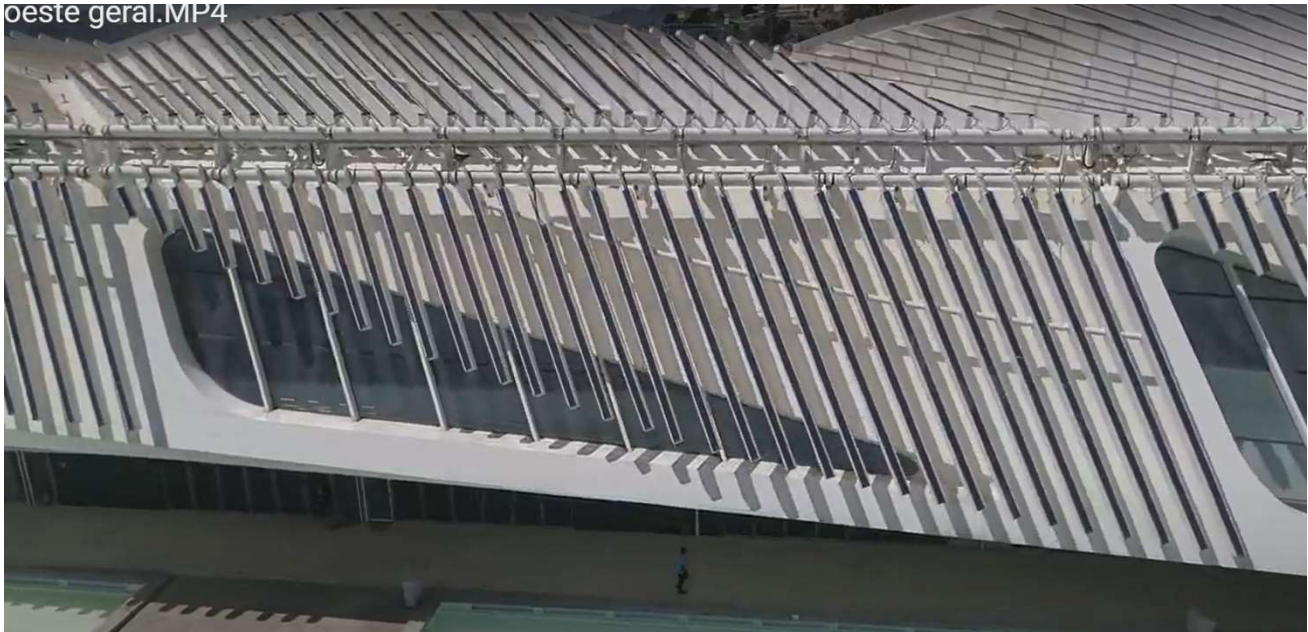
FOTO 50 – LATERAL OESTE ENTRE EIXOS G2 e G3
