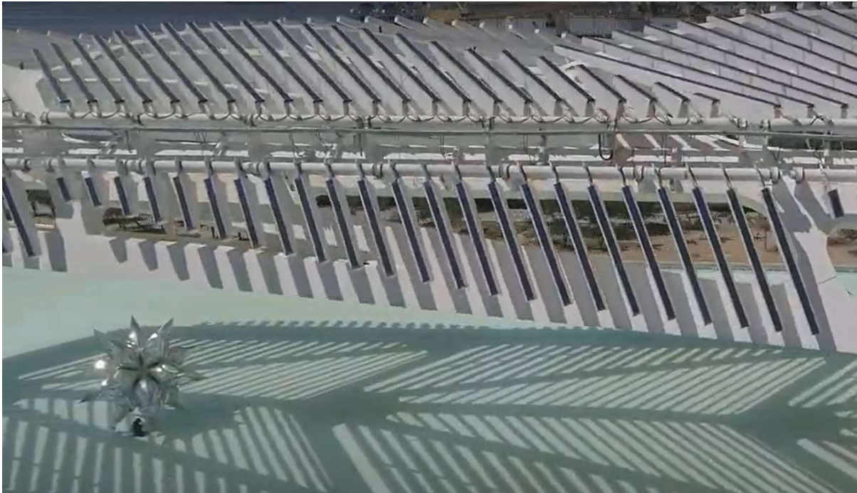
FOTO 53 – LATERAL OESTE ENTRE EIXOS G5 e G6
