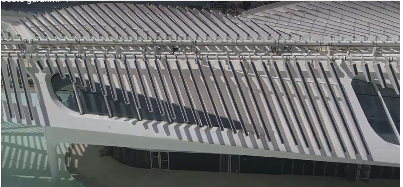
FOTO 51 – LATERAL OESTE ENTRE EIXOS G3 e G4
