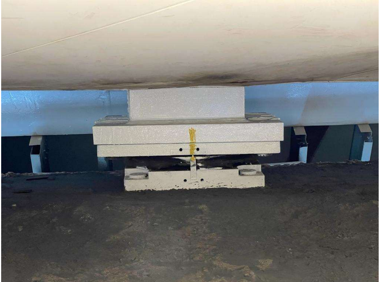
FOTO 04 – APARELO DE APOIO SUPERIOR*
