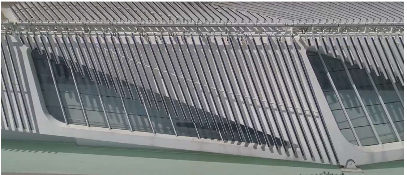
FOTO 48 – LATERAL OESTE ENTRE EIXOS G-1 e G1
