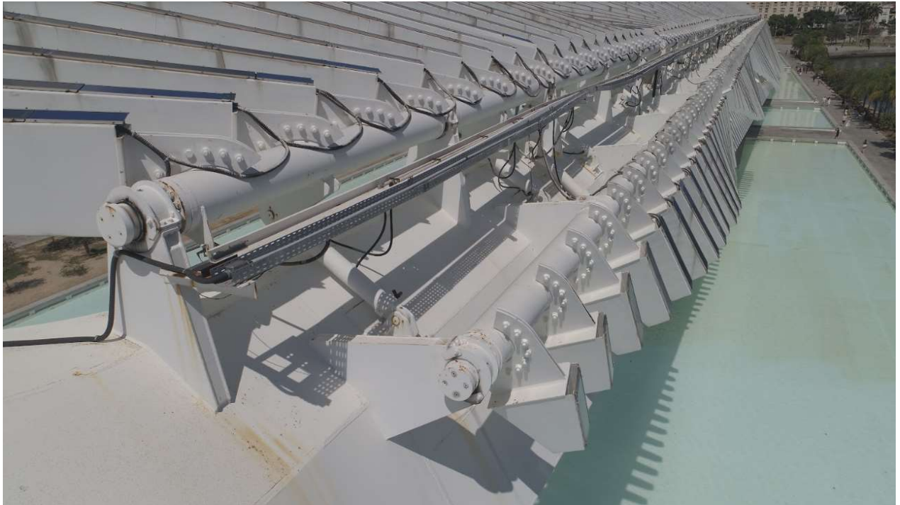
FOTO 61 – EIXOS DE MOVIMENTAÇÃO DAS ALETAS OESTE
