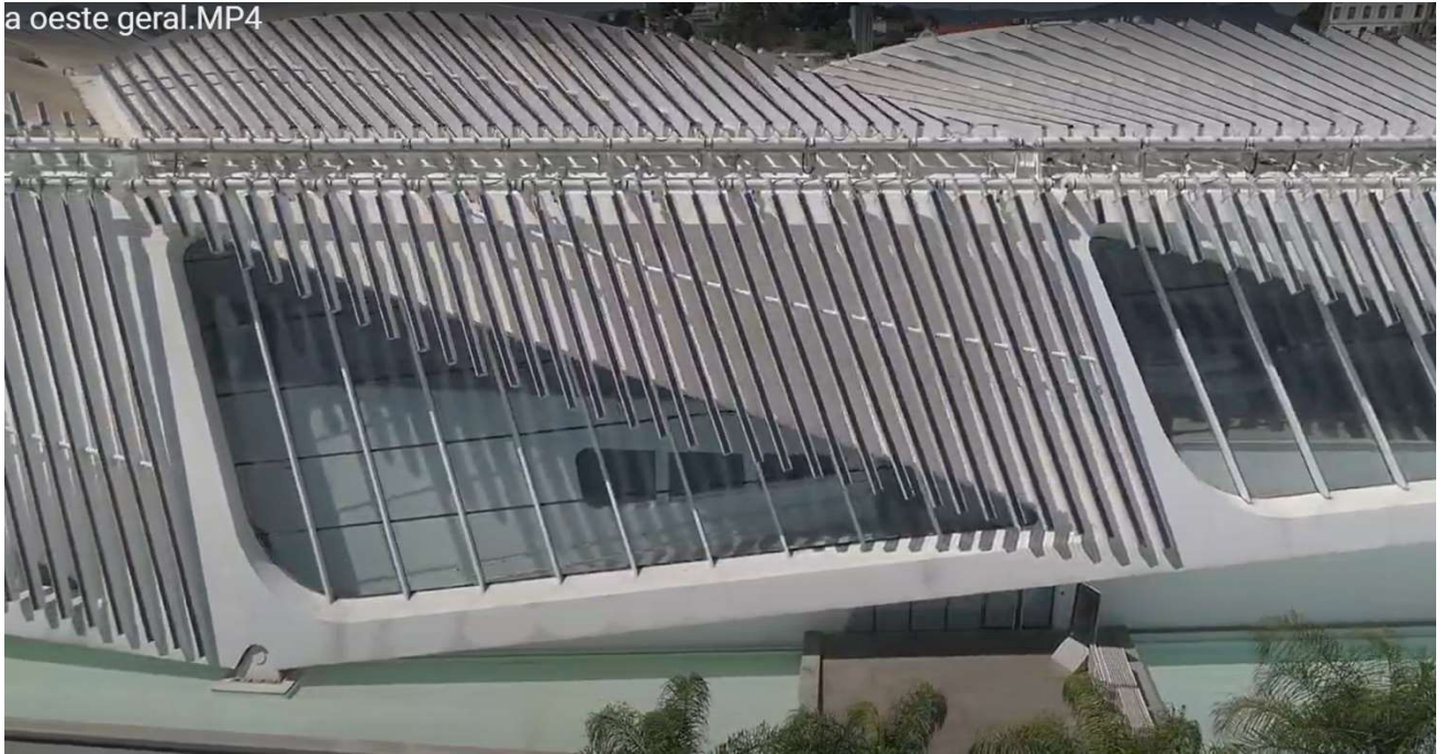
FOTO 47 – LATERAL OESTE ENTRE EIXOS G-2 e G-1
