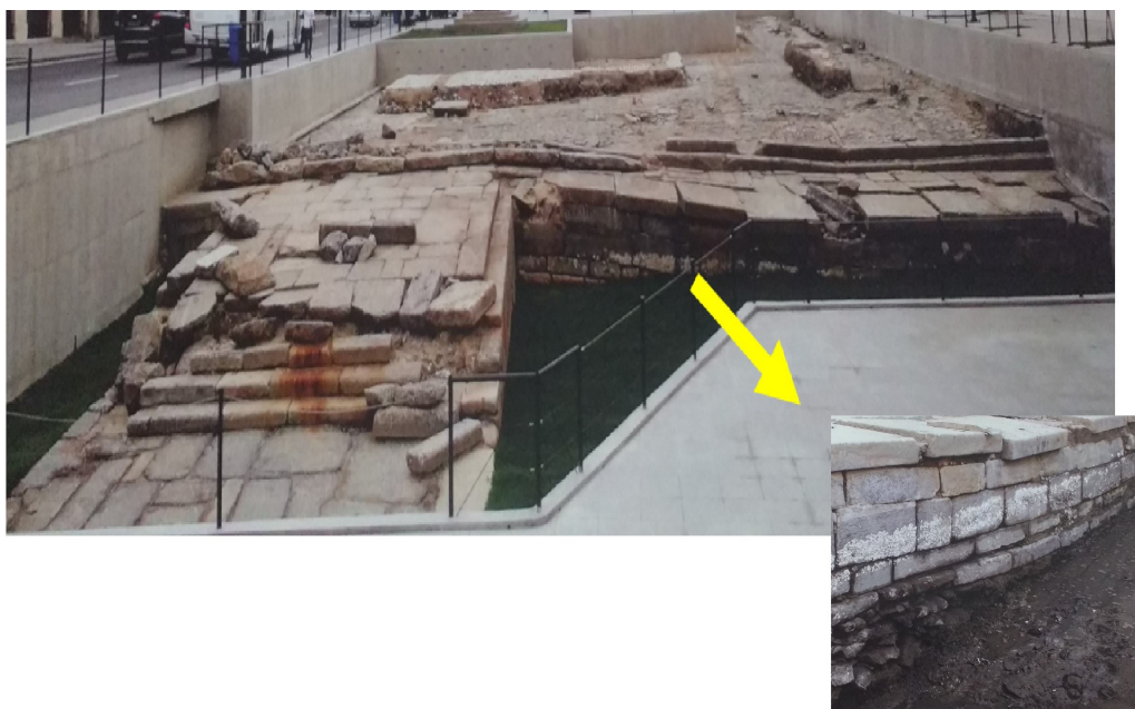
Figura 01: Detalhe das carapaças de ostreídeos aderidas na parede esquerda da rampa de desembarque.
